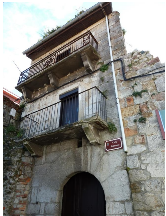
Fotografía 24: Torre del Merino en Ruamayor.
