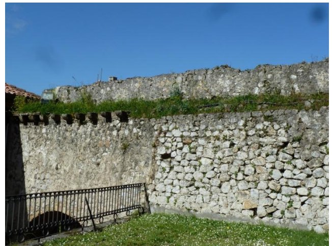
Fotografía 2: Puebla Vieja: muralla, lienzo Oeste interior. Por encima de la puerta de Santa María, se aprecian restos del paso de ronda
