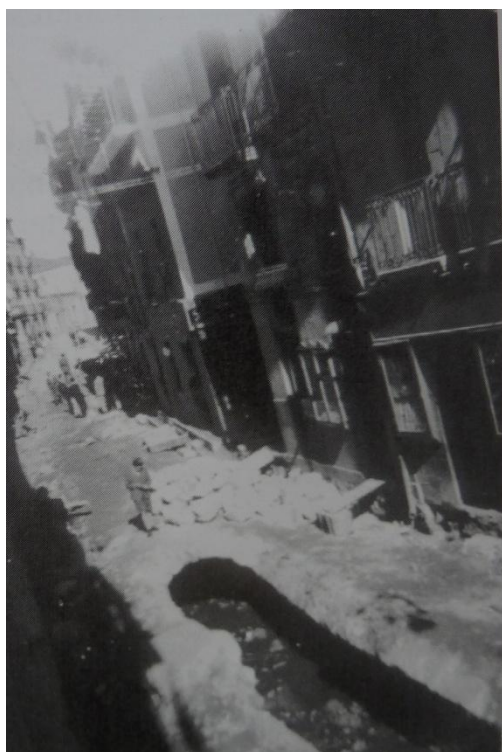
Fotografía 39: Calle Revellón en obras (Ferrerías o del Mercado). Durante las obras quedó al descubierto la canalización del río Bario. BRÍGIDO GABIOLA, Baldomero: La Puebla Vieja y el Arrabal de la villa de Laredo. Configuración urbana y realidad social de Laredo en el siglo XVIII . Torrelavega, 2008, p. 54.
