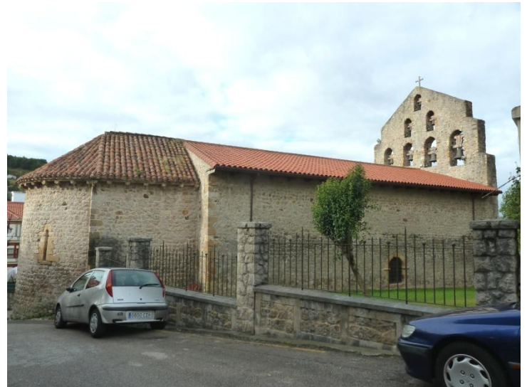
Fotografía 18: Iglesia de San Martín o Santa Catalina
