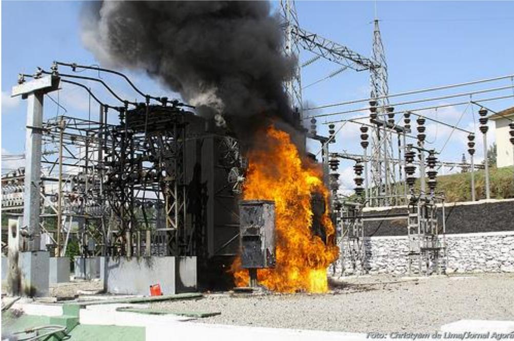
*Ilustración 18. Accidente incendio transformador*
