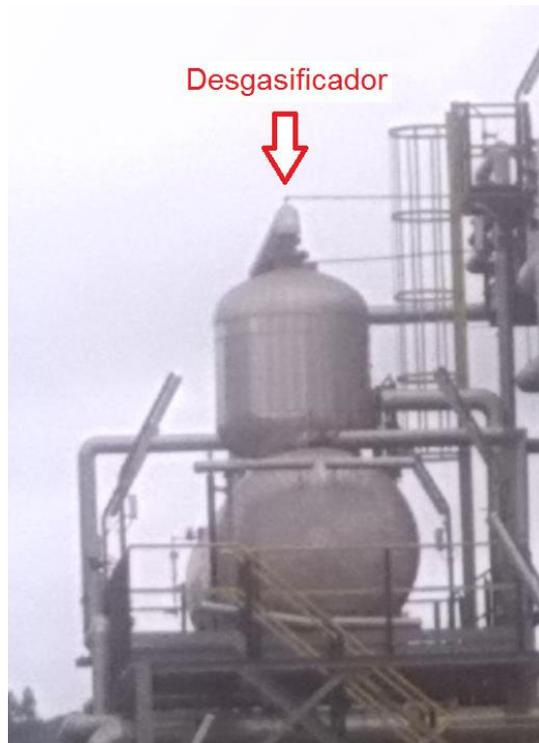
Actualmente el control de nivel del desgasificador se realiza manualmente arrancando y parando las bombas que suministran el agua al desgasificador.
