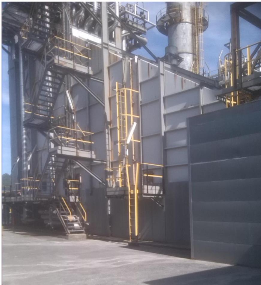
La caldera de recuperación de calor en un ciclo combinado es el elemento que aprovecha la energía de los gases de escape de la turbina de gas transformándola en vapor. Con posterioridad, ese vapor puede transformarse en electricidad en el turbogrupa, ser utilizando directamente (en todo o en parte) en procesos industriales o bien emplearse en la producción de calor en sistemas de calefacción centralizados.
