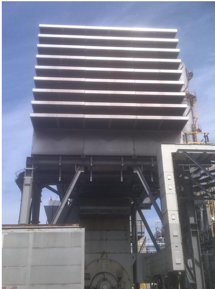
**Silenciador:** pantalla con un mallado de 800 micras que está justo antes de la entrada al compresor de baja presión.
