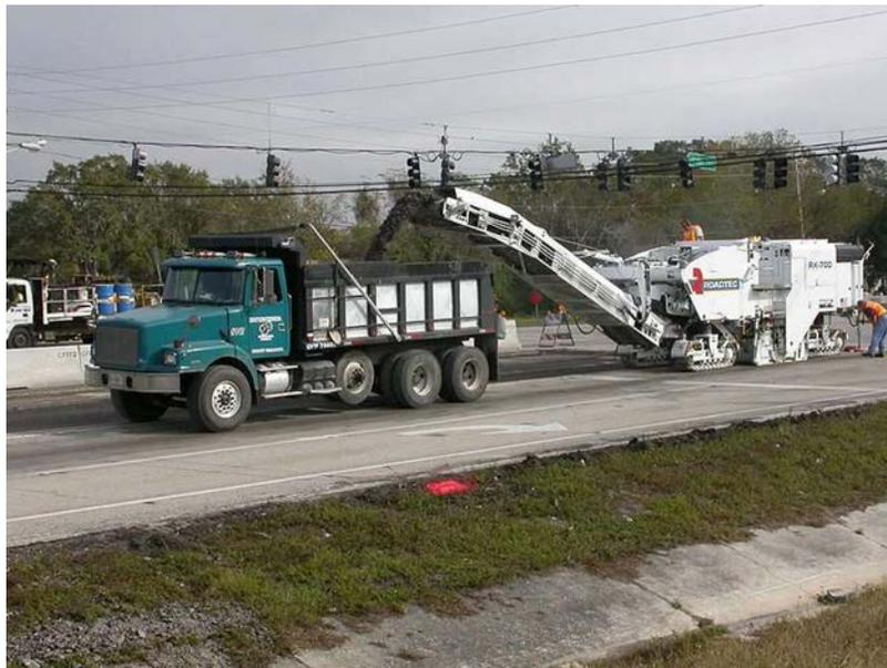
*Fig. 18 Fresado y carga en bañera.*
