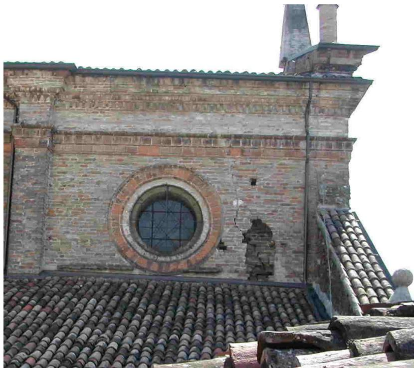
Figura 2.2.3.1.7. Hendidura en la pared exterior de una iglesia: el acceso a la zona requiere el uso de andamios o de elevación.
