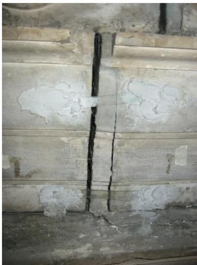
Figura 2.2.3.1.8.2. Salón de Tintoretto, Gran Escuela de San Rocco. Sensor SR11 instalado para vigilar la grieta.
