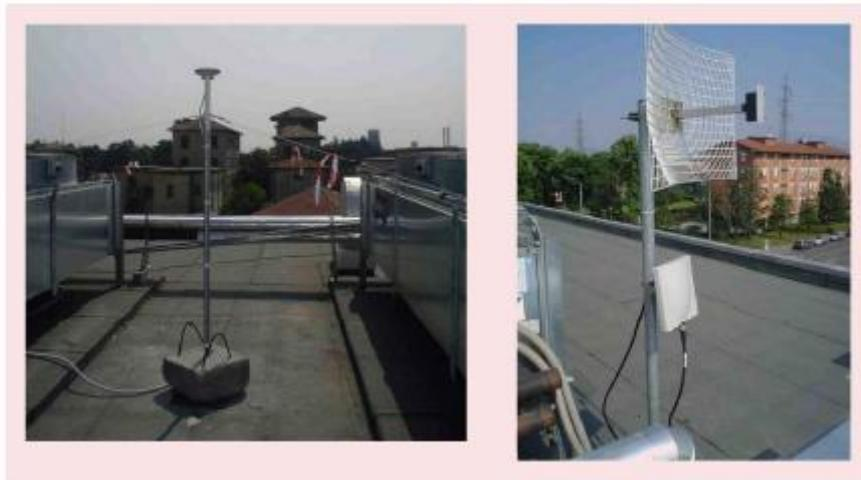
Figura 2.4.6.3.1. Antena de recepción GNSS (izquierda) y de comunicación Wlan (derecha).
