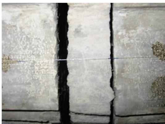
Figura 2.2.3.1.8.4. Salón de Tintoretto, Gran Escuela de San Rocco. SR11 sensor instalado para vigilar la grieta.
