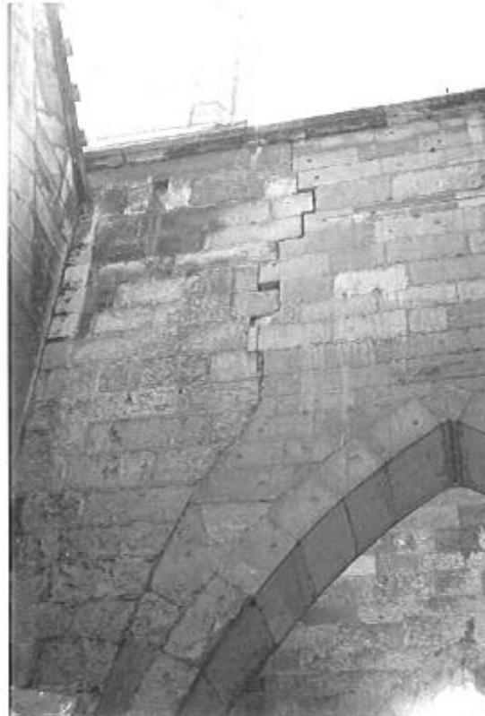
Figura 3.2.6. Vista del muro oeste desde la parte interior que muestra la amplia grieta y la fractura previa a la restauración.
