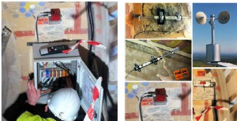
Figura 3.1.17. (a) Estación remota, terminales. (b) Algunos sensores instalados.
