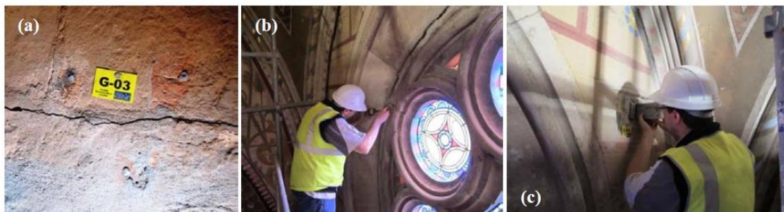
Figura 3.1.8. (a) Puntos de control manual para el seguimiento de la grieta G-03 ubicada sobre el abovedado. (b) Registro manual de la apertura de la grieta G-06. (c) Registro manual de la inclinación I-05.
