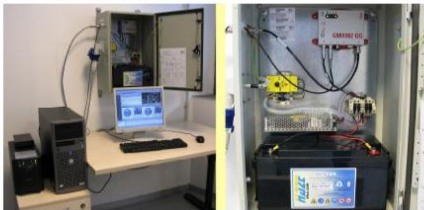
Figura 2.4.6.3.2. Server del sistema y receptor de satélite de la estación Master.
