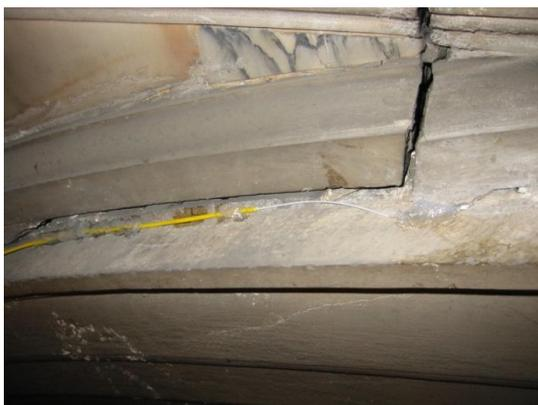
Figura 2.2.3.1.8.3. Salón de Tintoretto, Escuela de Gran Sanrocco. Terminación del SR1 dorsal, lado sensor SR11.
