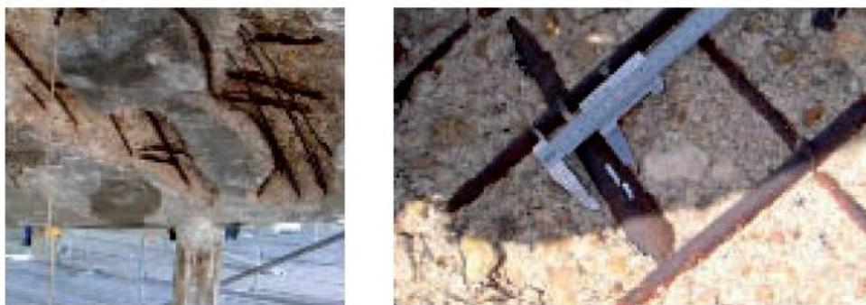
Figura 3.3.10. Presencia de una corrosión generalizada.
