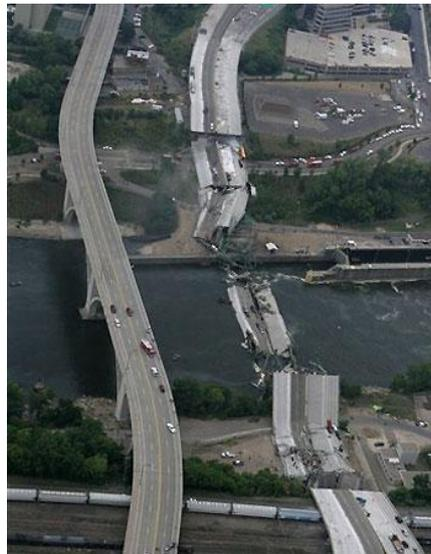
Figura 1.2 Colapso de un puente sobre el río Missisipi en Mineapolis, USA.
