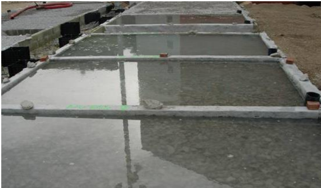
Pruebas de estanqueidad de las plazas.
