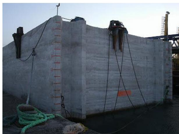
Figura 3-15 Cajón con los dispositivos de remolque instalados
