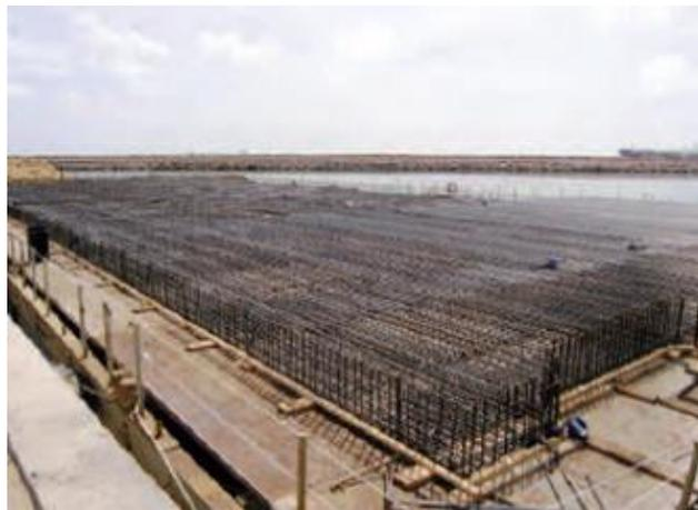
Figura 3-8 Armadura de la solera
