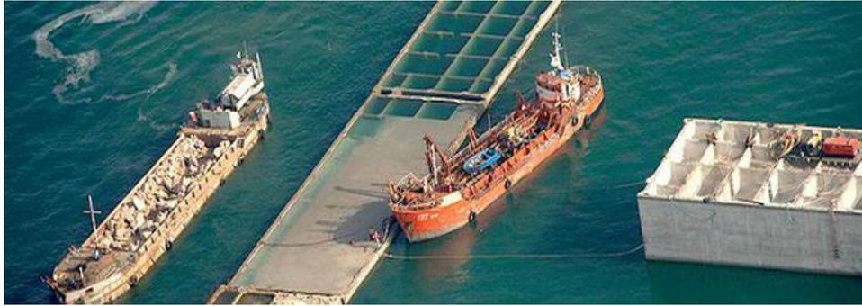
Figura 3-16 Relleno de cajón rectangular
