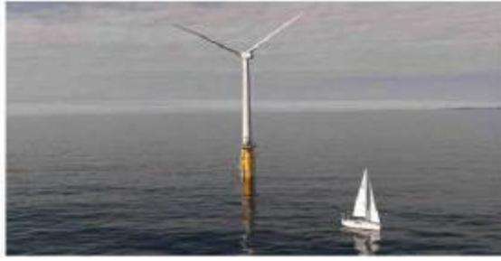
Figura 2-6 Plataforma Spar Hywind
