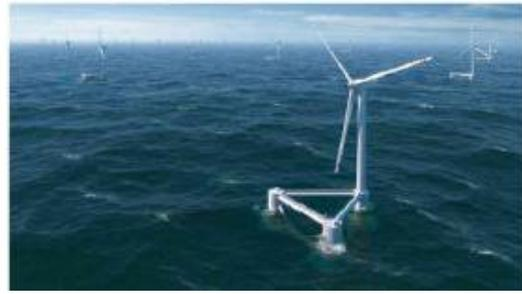
Figura 2-7 Plataforma semisumergible Windfloat
