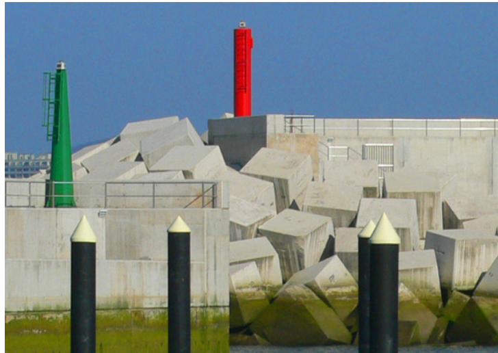
Figura 4.9. Bloques del dique del actual puerto
