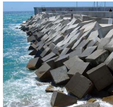
Figura 2.29. Cubos de hormigón
