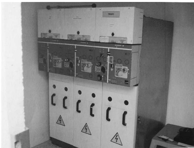
ILUSTRACIÓN 11. INSTALACIÓN DE CELDAS ACTUAL EN EL CT "GALLERY"
