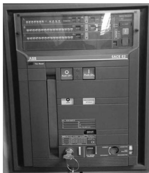
ILUSTRACIÓN 6. CELDA DE INTERRUPTOR AUTOMÁTICO ABB EMAX2 CON PROTECCIÓN TÉRMICA
