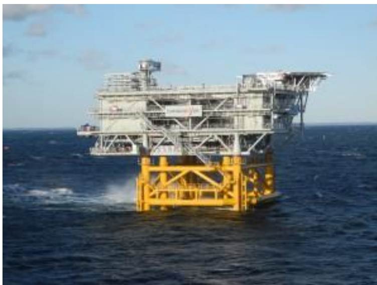
Figura 3.6 Plataforma tipo jacket.
