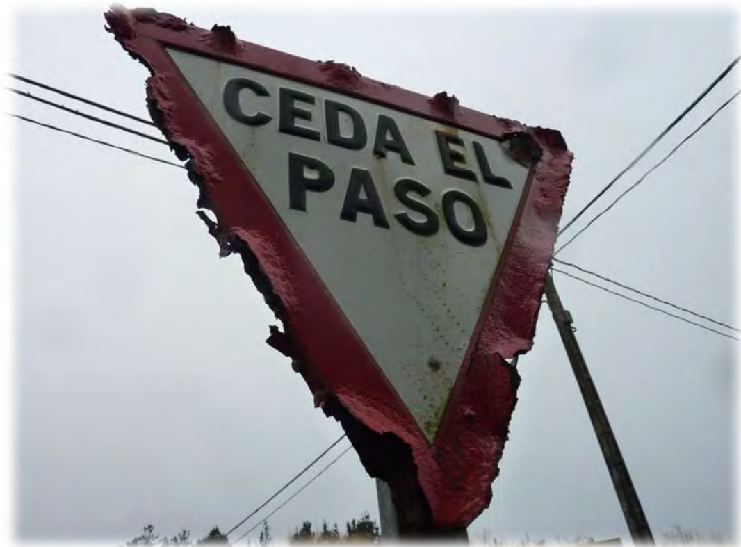
Figura 5. “Ejemplo de corrosión en señal de tráfico, Loredó (Cantabria)”
