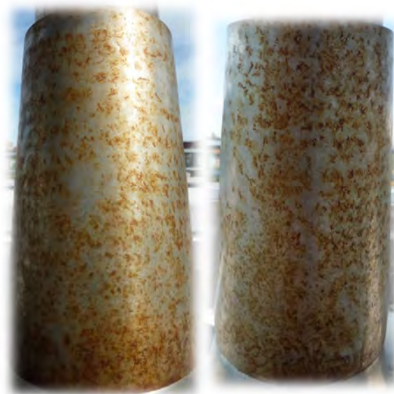
Figura 129. “Casquillo 5 de Puente Juan José Arenas”
