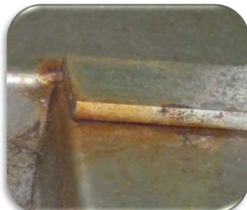
Figuras 22 y 23. “Ejemplos de zonas propensas a corrosión en resquicios”
