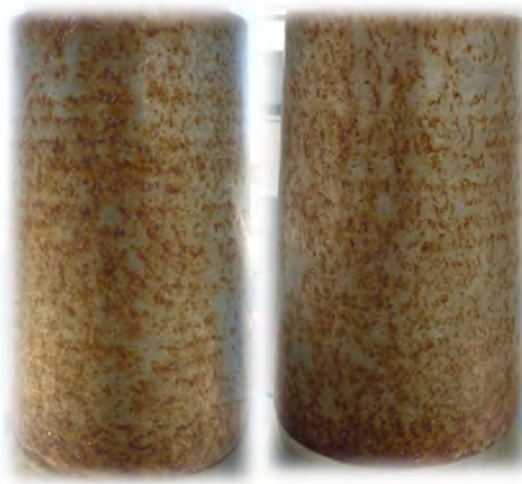
Figura 133. “Casquillo 6 de Puente Juan José Arenas”
