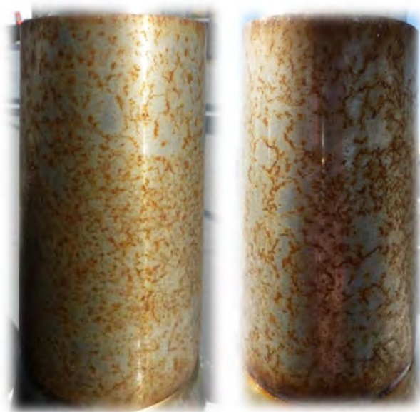
Figura 125. “Casquillo 4 de Puente Juan José Arenas”
