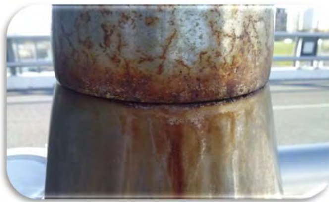
Figura 20. “Corrosión en resquicios que se aprecia en la parte inferior de los casquillos”
