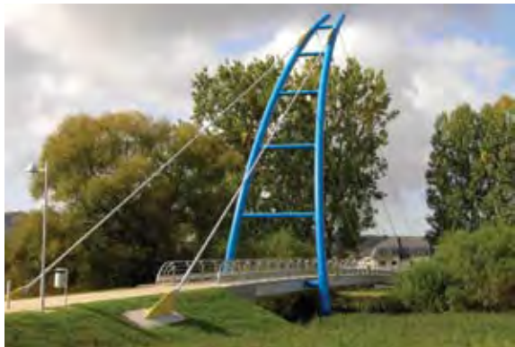
Fußgängerbrücke Walverdang, Luxembourg Contractor: Bohlen AG, Speicher
