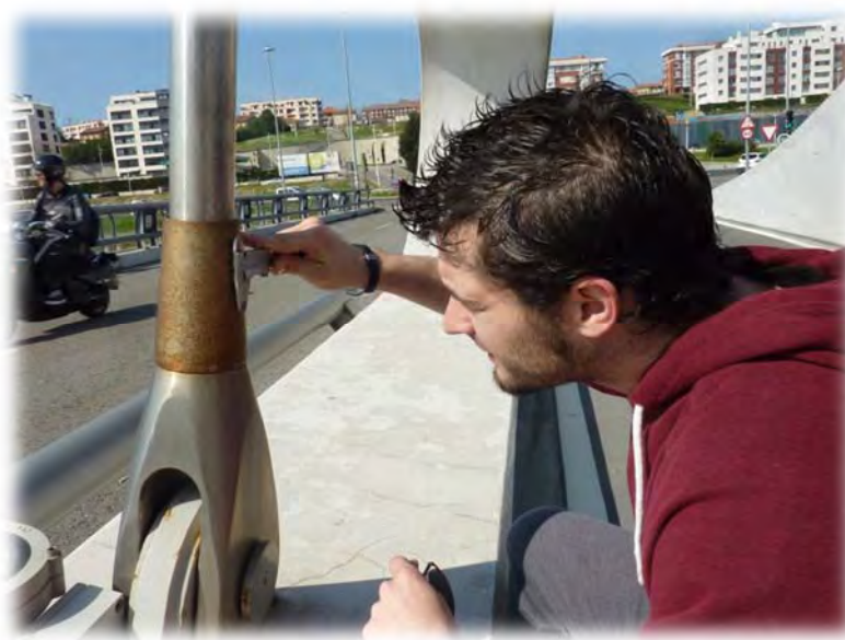
Figura 97. “Tomando mediciones del tamaño de la picadura”
