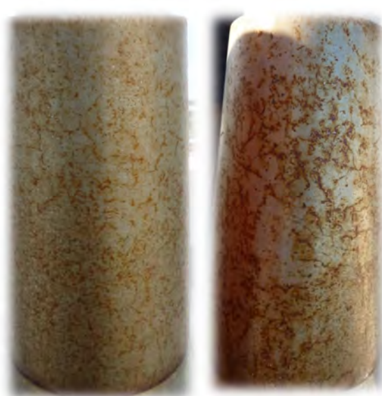
Figura 141. “Casquillo 8 de Puente Juan José Arenas”
