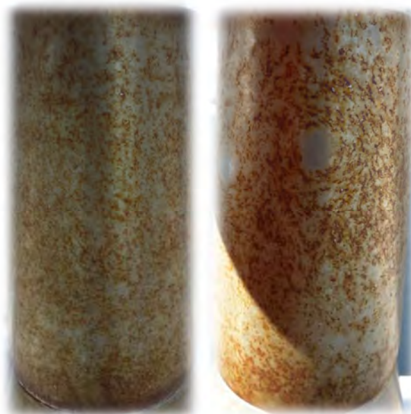
Figura 145. “Casquillo 9 de Puente Juan José Arenas”
