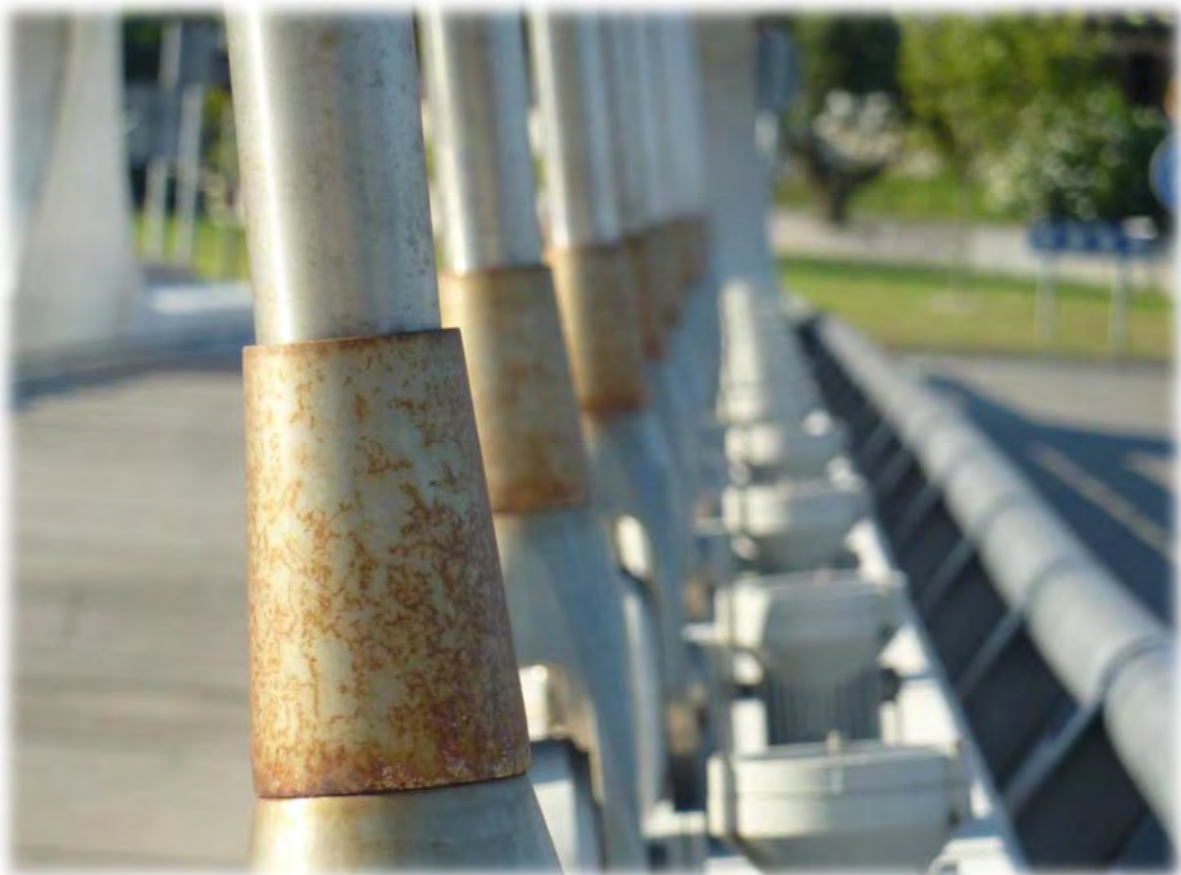
Figura 3. Tirantes y casquillos del “Puente Juan José Arenas”, Santander
