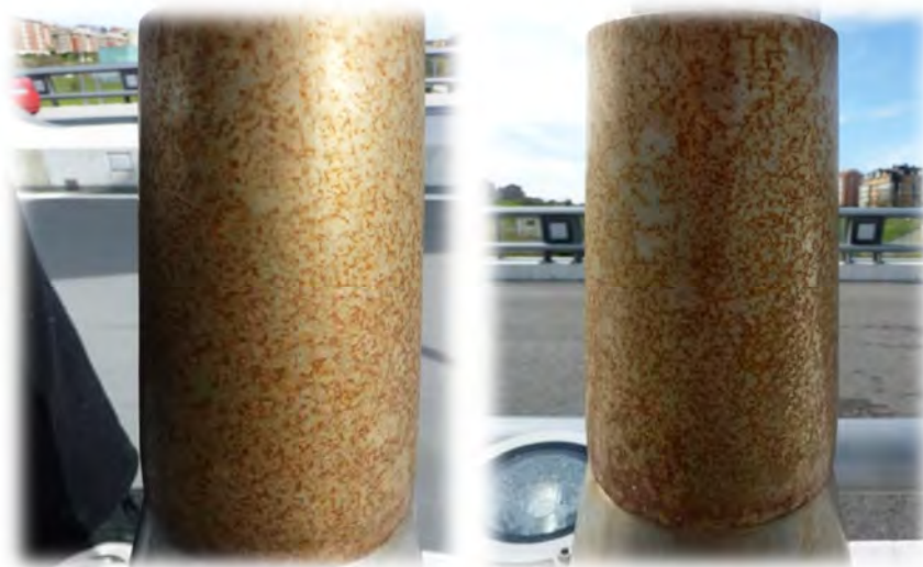
Figura 113. “Casquillo 1 de Puente Juan José Arenas”
