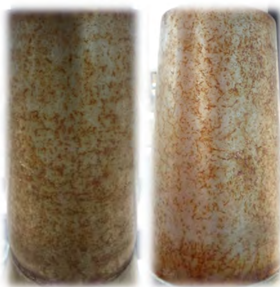
Figura 149. “Casquillo 10 de Puente Juan José Arenas”
