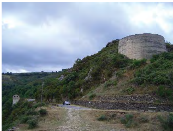
Figura A.48 - Chimenea de equilibrio de la central del embalse de Prada (Galicia)
