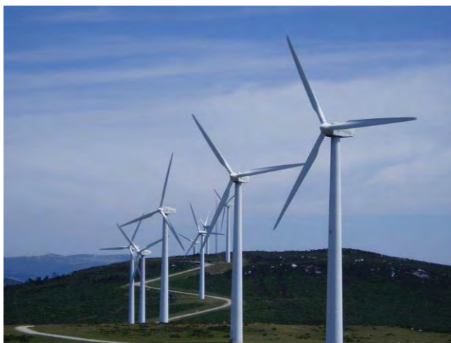
Figura A.4 - Campo Eólico
