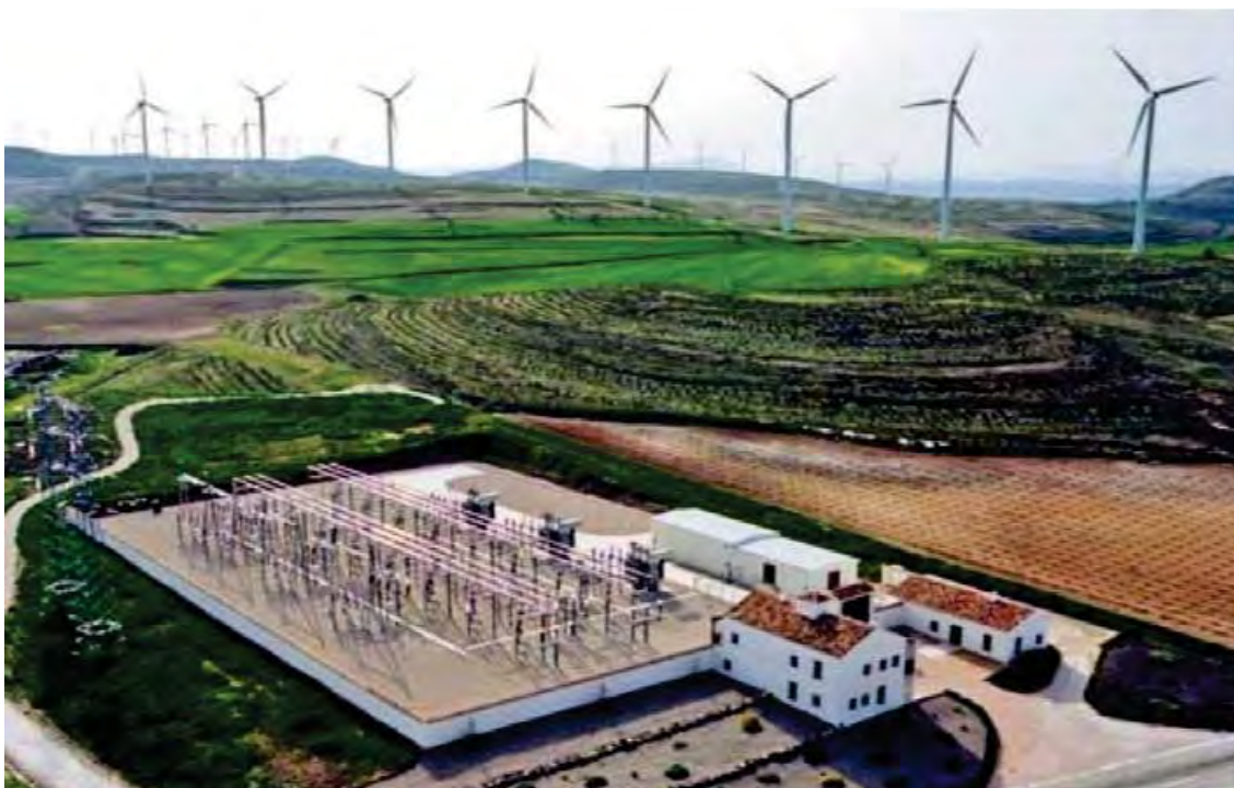
Figura A.6 - Subestación Eléctrica y Campo Eólico.
