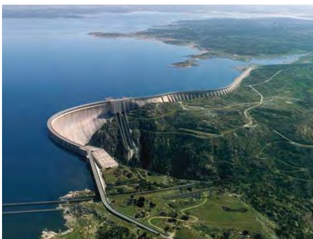
Figura A.51 - Presa de arco de Salamanca
