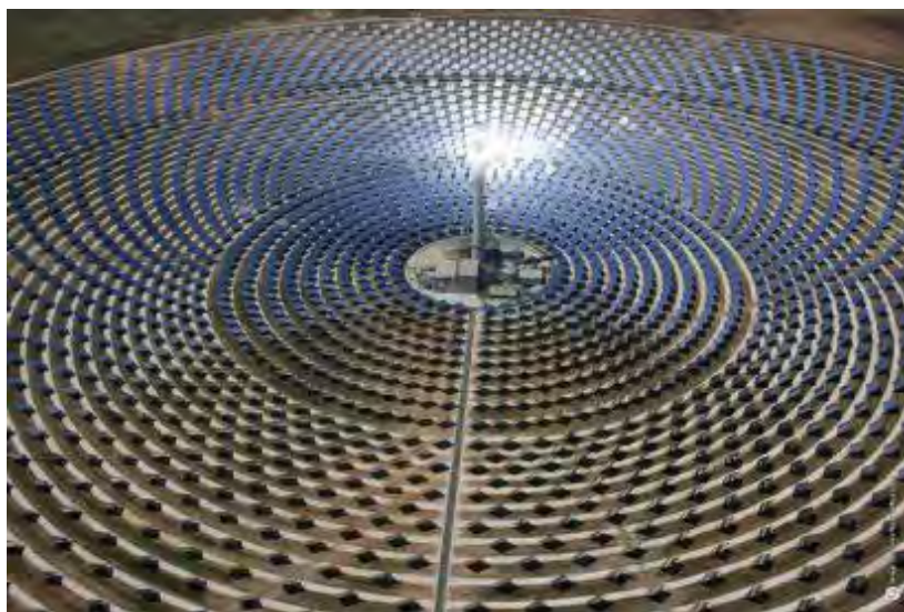
Figura 1.8 – Visión aérea de central termo-solar de torre central
