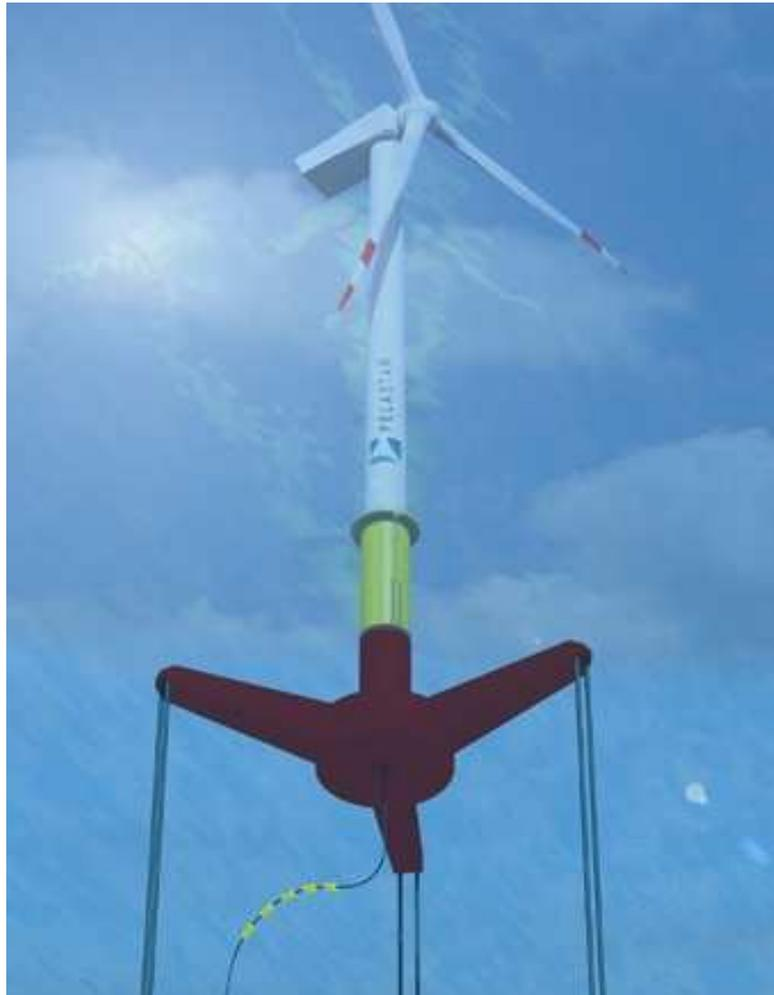
**Figura 1.8:** Aerogenerador flotante marino tipo TLP (Fuente: *Pelastar*)
