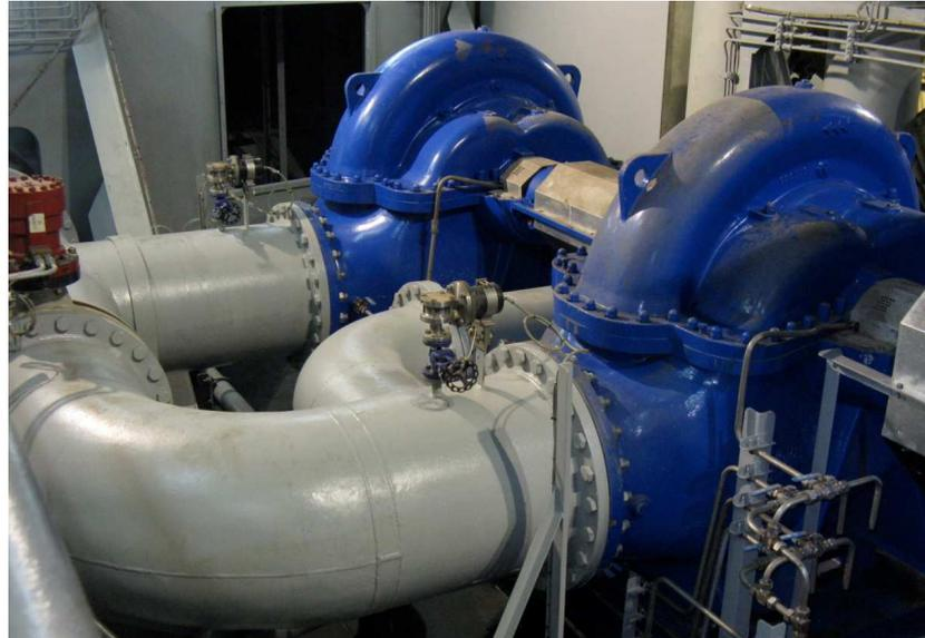
Se trata de dos bombas centrifugas idénticas marca Nijhuis con un flujo nominal de 1750 m<sup>3</sup>/h a una velocidad de 990 rpm en alta.
