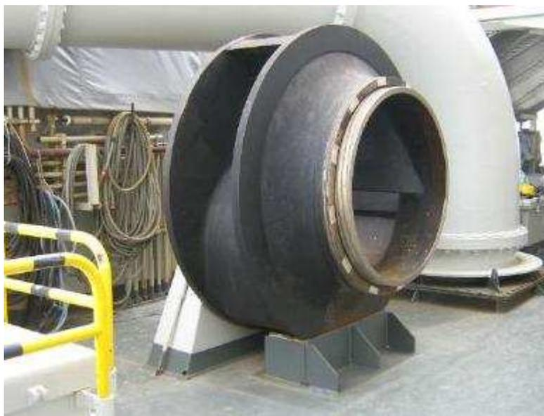
El impelente se conecta con el eje del electromotor por medio de un acople tipo “Ringfeder”. Del mismo modo que la bomba de descarga, la bomba está equipada con un sistema de limpieza con agua a presión “Gland system” encargado de mantener el eje del motor libre de sedimento.
