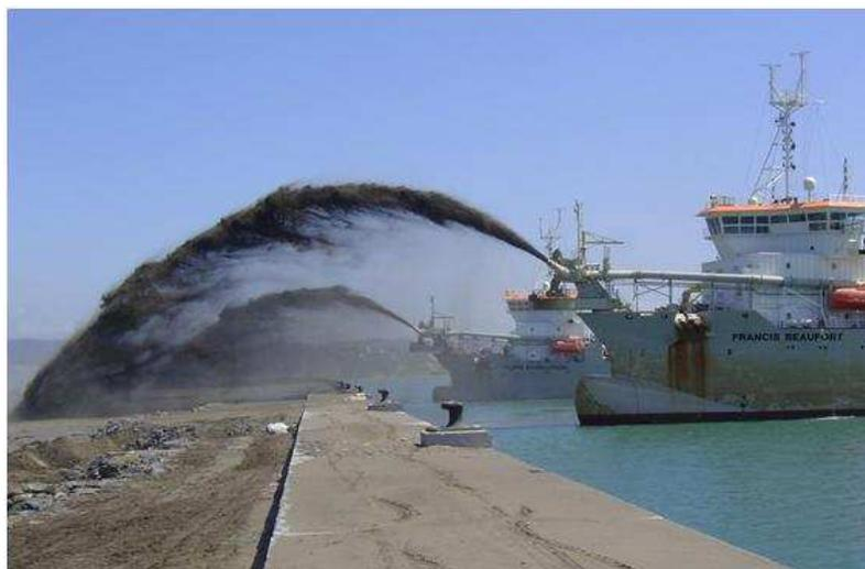
La realización de obras portuarias exige la excavación de las dársenas y zonas de giro y el relleno de las zonas de muelles. Cuando el material es apto se trata de compensar volúmenes de excavación y relleno. Esta excavación es más eficiente y económica realizarla mediante dragas avanzando y abriendo camino desde el agua
