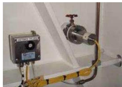
Dos Transducers de acero inoxidable con plataforma de gravedad estabilizada de medición inductiva de inclinado para el calculo del Asiento y Escora (4-20 mA - 10/+10V)
