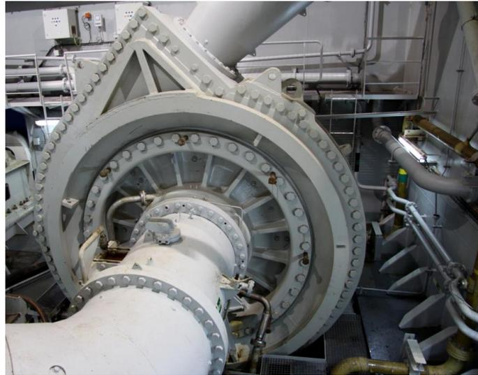
Impelente de tipo cerrado de cuatro palas, con un diámetro de 2.6 mts
