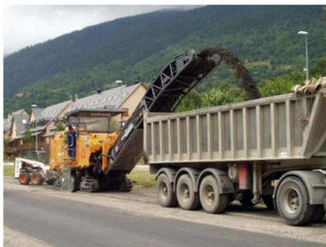
**Figura 2-20. Reciclado de pavimentos Asfálticos**
