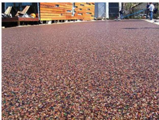
**Figura 2-11. Pavimento de vidrio reciclado.**
