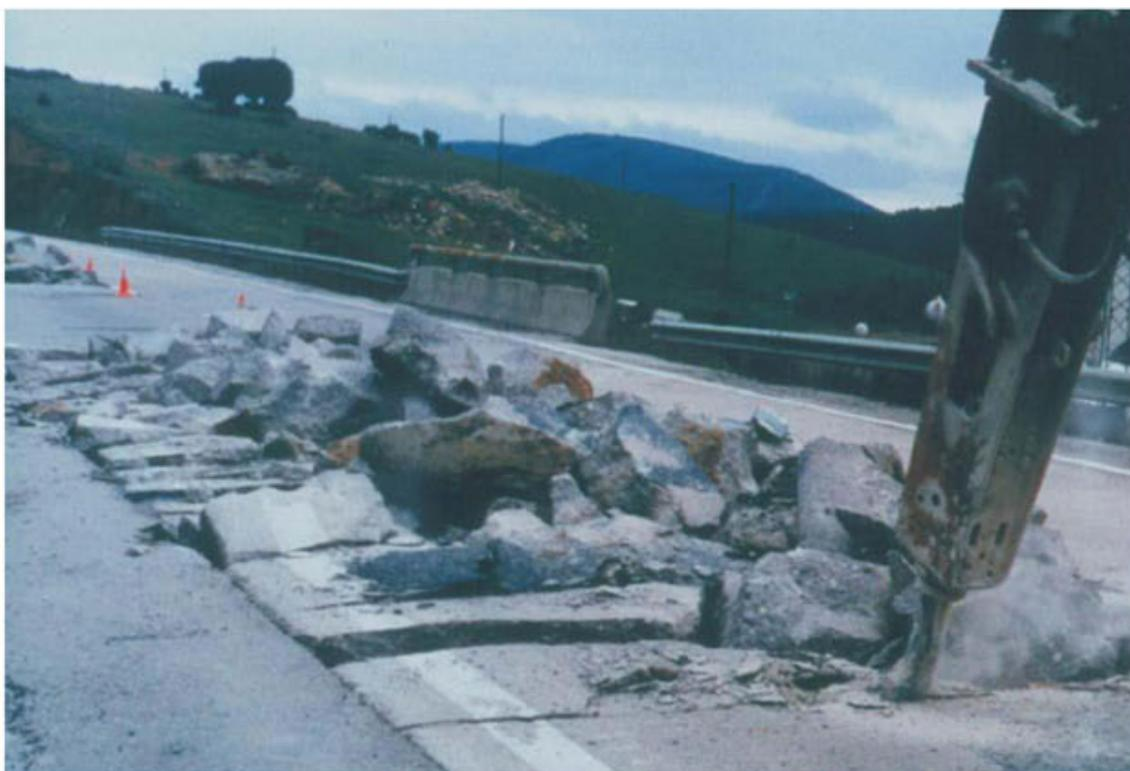
**Figura 2-21. Demolición de pavimento de hormigón**
