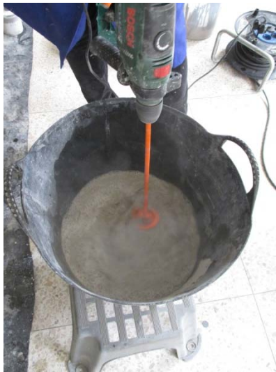
Fig. 37. Mezclador acoplado al taladro empleado para amasar la lechada de cemento.
