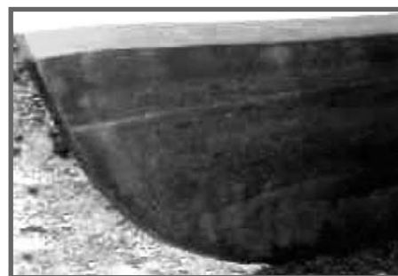
Fig. 9. -Estado final de la superficie tratada con la pintura 20.
