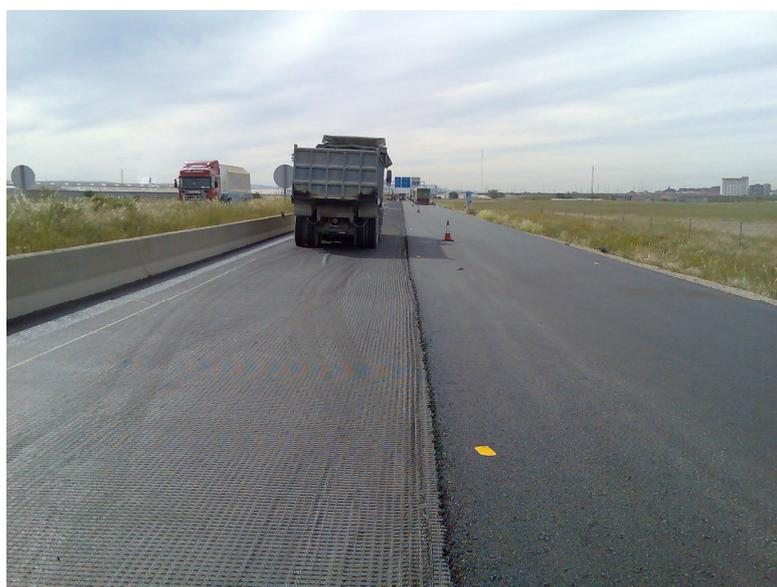
Figura 2.34 Paso de vehículos por sobre una geomalla instalada
