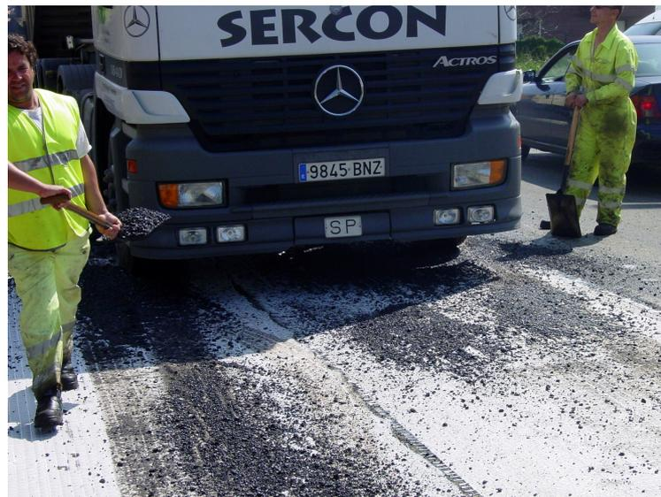
Figura 2.35 Movimiento de vehículos sobre el geosintético durante el proceso de extensión de la mezcla
