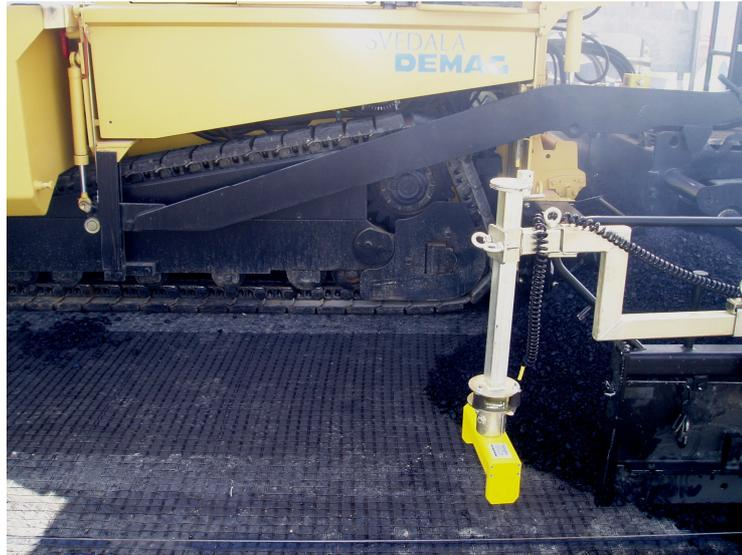
Figura 2.36 Colocación de mezcla sobre geosintético
