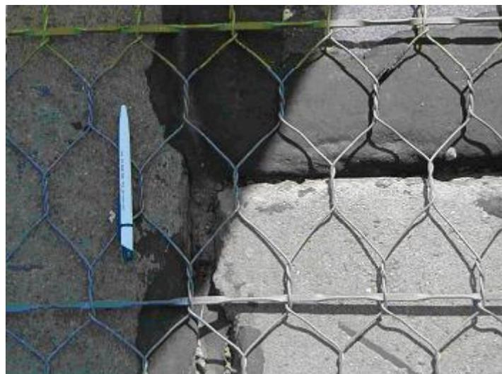
Figura 2.13 Malla de doble torsión reforzada con alambre plano torsionado
