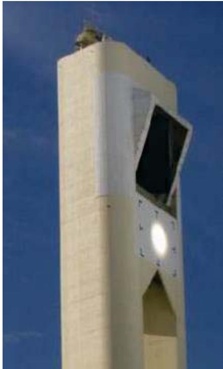
*Figura 10. 1 Receptor solar de cavidad de la planta solar PS10 (Sevilla)*
