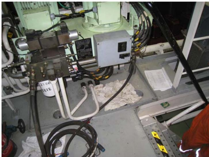
Fig.7 Conexión de manguera para accionamiento de emergencia.
