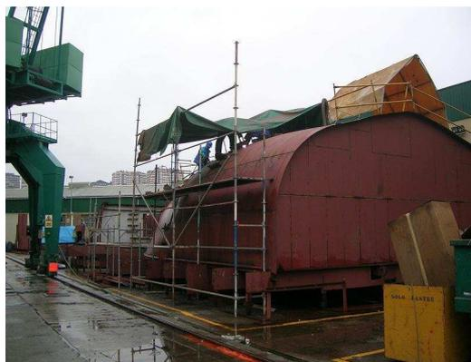
El casco del buque es de estructura transversal, construido en acero soldado con chapas y perfiles de acero naval de calidad y escantillonado aprobados por la Administración y la Sociedad de Clasificación, reforzados
