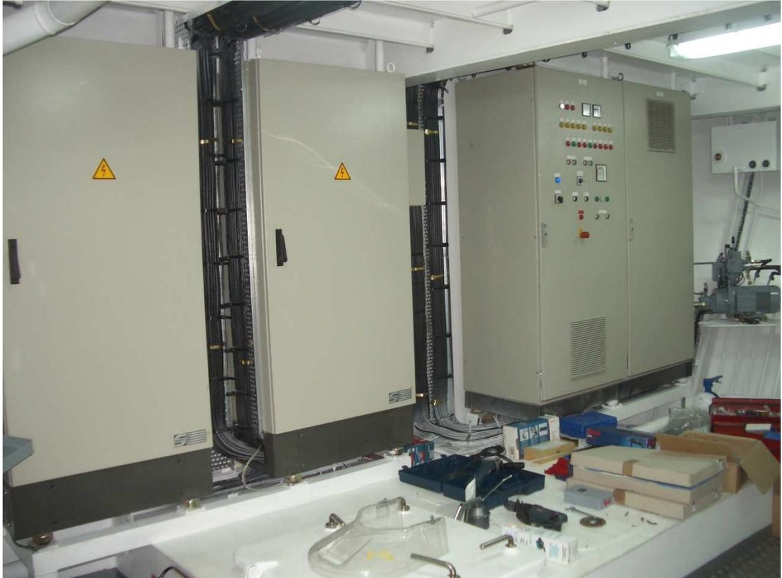
La instalación dispone de 4 alternadores de igual potencia que permite en navegación utilizar un alternador que puede dar servicio completo al buque y mediante el uso de dos, tres o los cuatro alternadores acoplados en paralelo dar servicio en condiciones especiales como es el caso de suministro a otros buques.
