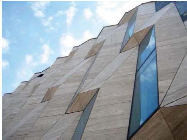
**Figura 27.** Detalle de una fachada con revestimientos con estructuras sándwich
