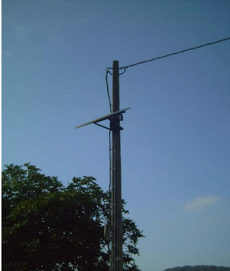
**Figura 3.6. Soporte metálico anclado en poste de hormigón**
