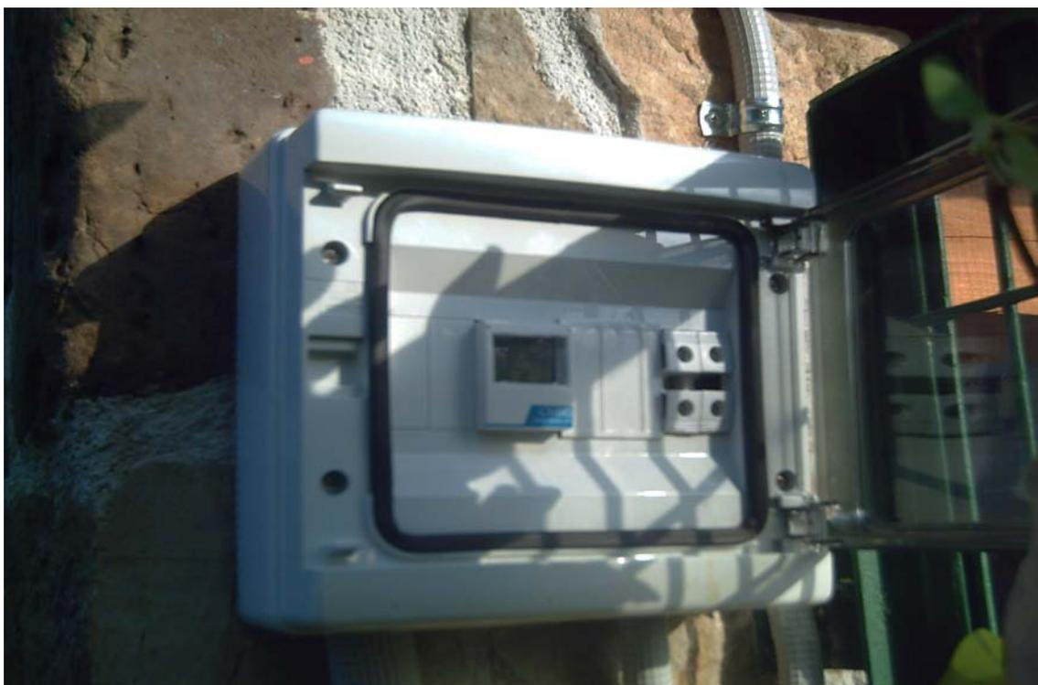
**Figura 3.9. Interruptor horario astronómico instalado en una caja estanca**
