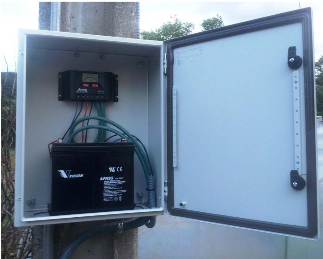
Figura 3.8. Conjunto regulador-acumulador en el interior del armario metálico
