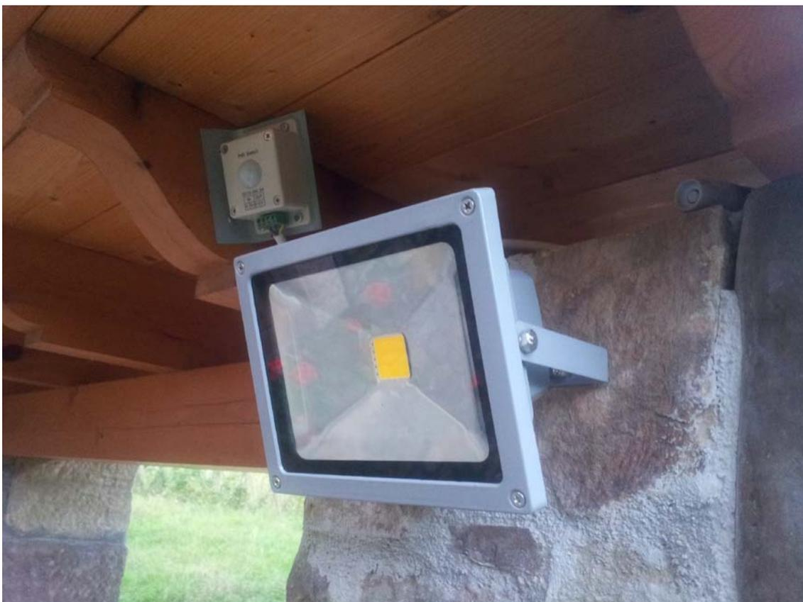
Figura 3.10. Conjunto proyector LED y detector PIR
