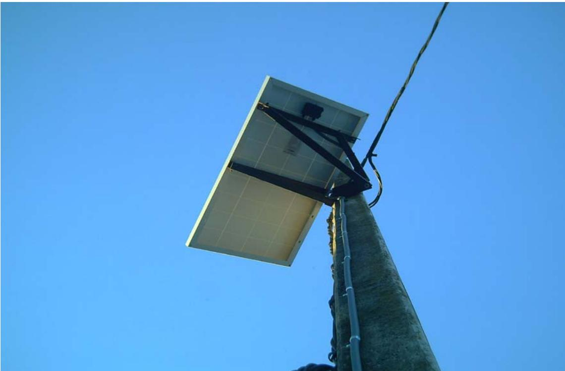
**Figura 3.12. Conjunto placa-soporte en poste de hormigón**
