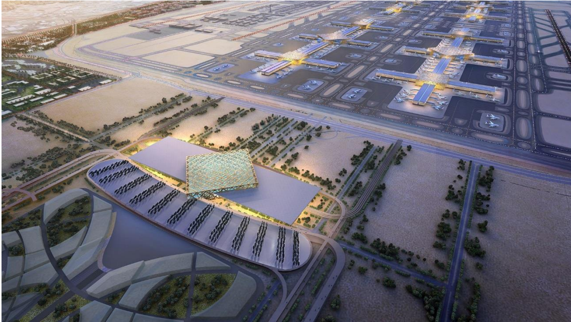
Figura 10. Diseño aprobado del nuevo terminal de pasajeros del Aeropuerto Internacional Al Maktoum (DWC), que muestra la proyección de sus cinco pistas, terminales radiales y zonas de embarque. Adaptación gráfica del diseño del nuevo terminal.
