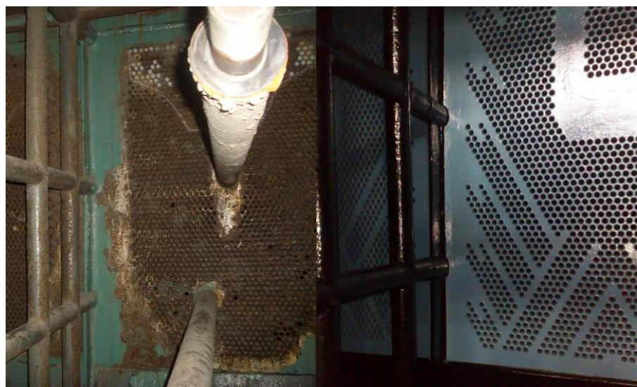
Figura 31. Aplicación Belzona 5811 en un intercambiador de calor. Fuente: [76]
