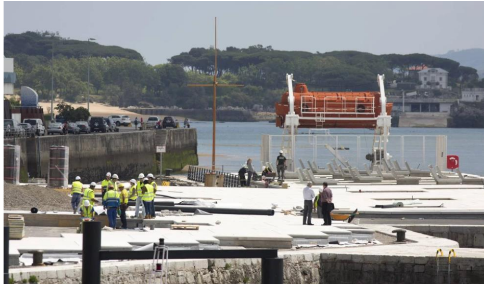
Figura 3. Obras del Muelle de Gamazo. Andrés Fernández. El Diario Montañés . (2015) Fuente: https://www.eldiariomontanes.es/fotos/santander/201506/18/instaladas-hamacas-gamazo-30111658490323-mm.html
