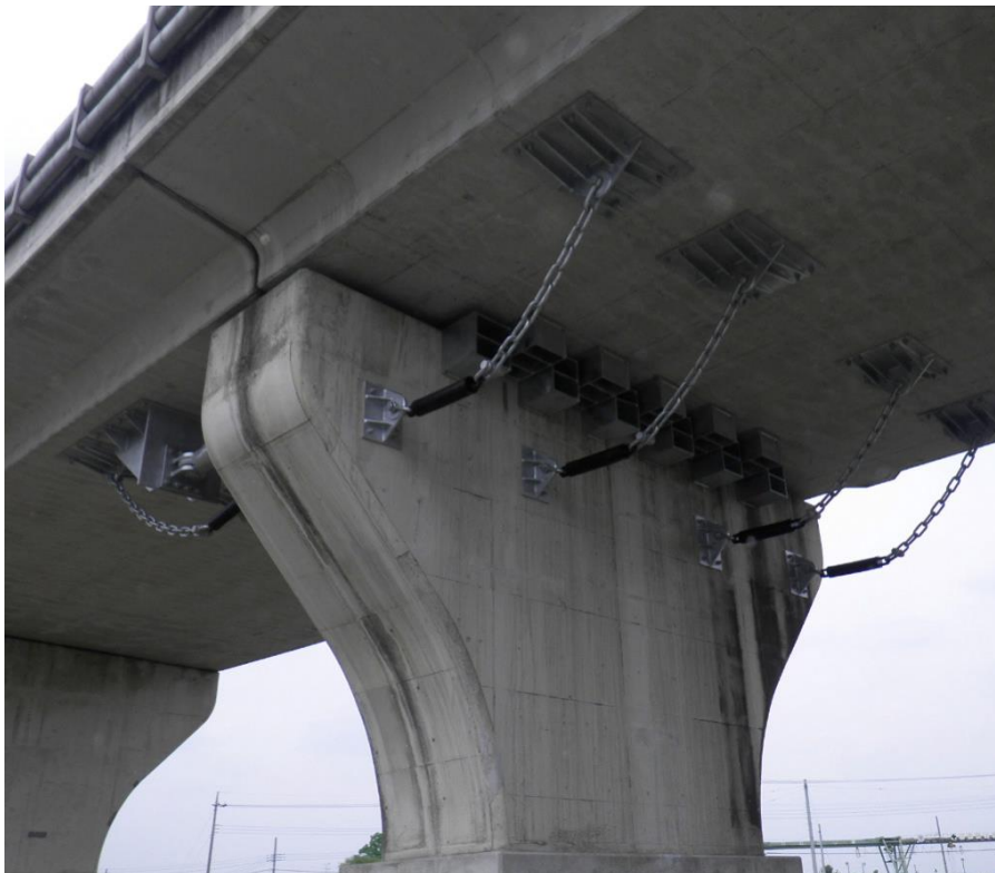
Figura 6.3 - Limitadores de movimientos longitudinales por cadenas. Fuente: structuraltechnologies.com
