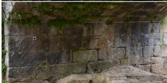
Pérdida de mortero en las juntas de las bóvedas
