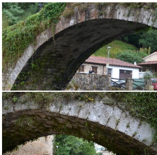
Éflorescencias salinas en las boquillas
