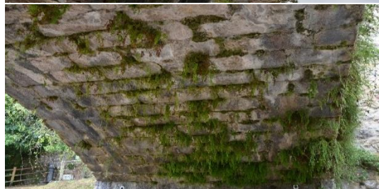
Vegetación incipiente en las juntas de las bóvedas
