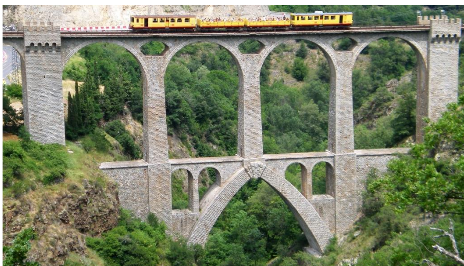
Figura 2-4: Pont Séjourné, un puente ferroviario de la línea de vía estrecha de Cerdagne [6].
