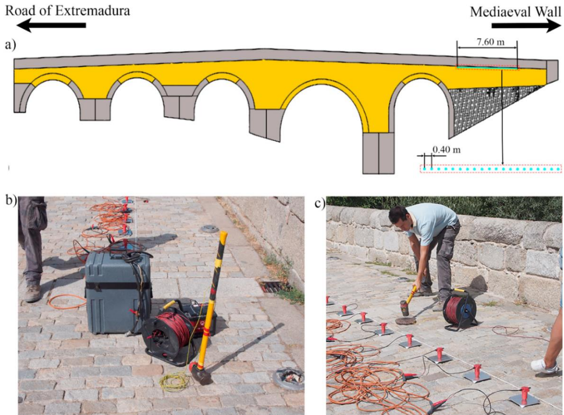
Figura 2-28: Ensayos MASW en el puente romano de Ávila: a) configuración; b) detalle del equipo utilizado y; c) momento en que se excita el relleno [16].
