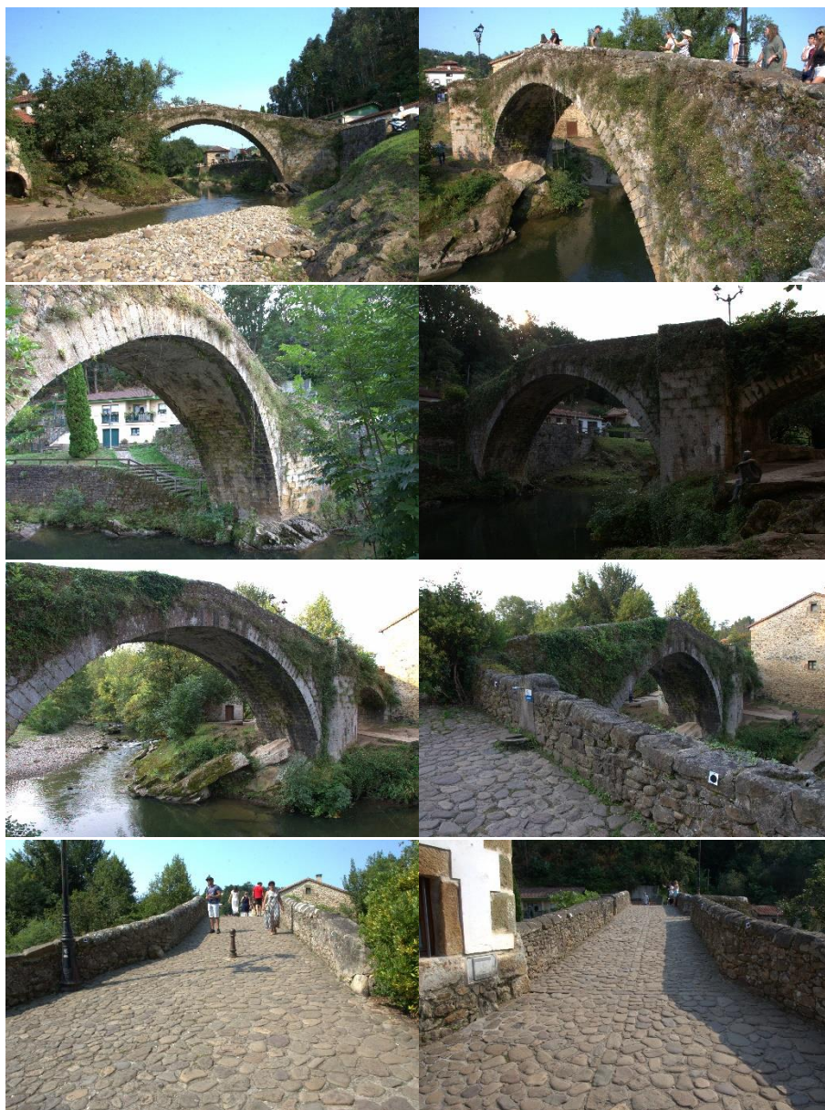
Figura 3-7: Fotos del Puente Mayor de Liérganes tomadas desde diferentes ángulos.
