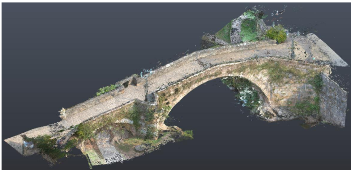
Figura 3-15: Nube de puntos procesada del Puente Mayor de Liérganes.
