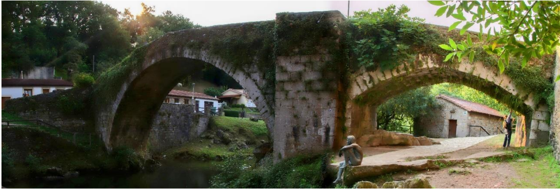
Figura 3-2: Fotografía panorámica general del Puente Mayor de Liérganes.
