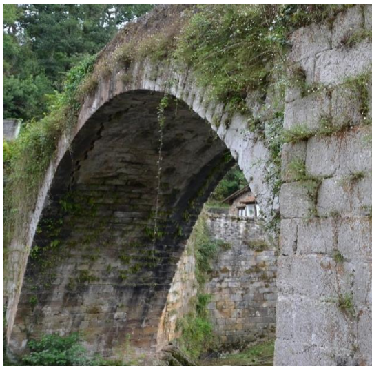
Agrietamiento de la bóveda mayor en la unión con la boquilla
