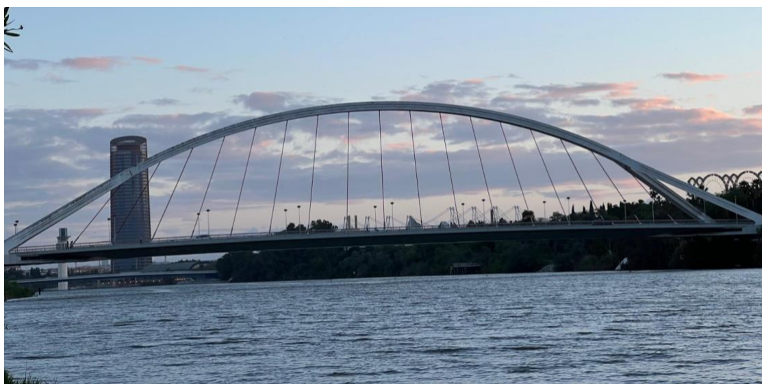
Figura 16. Puente de la Barqueta. Sevilla, España
