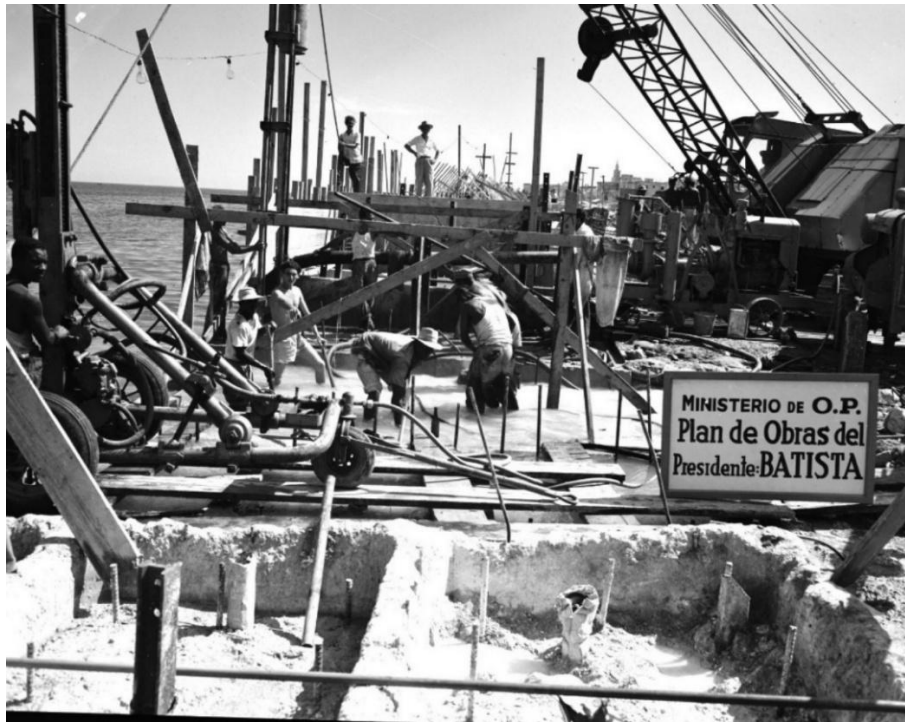
Ilustración 5: Hormigonado in-situ del Malecón. FUENTE: (GARCÍA, R. C., 2014, 20 DE NOVIEMBRE).
