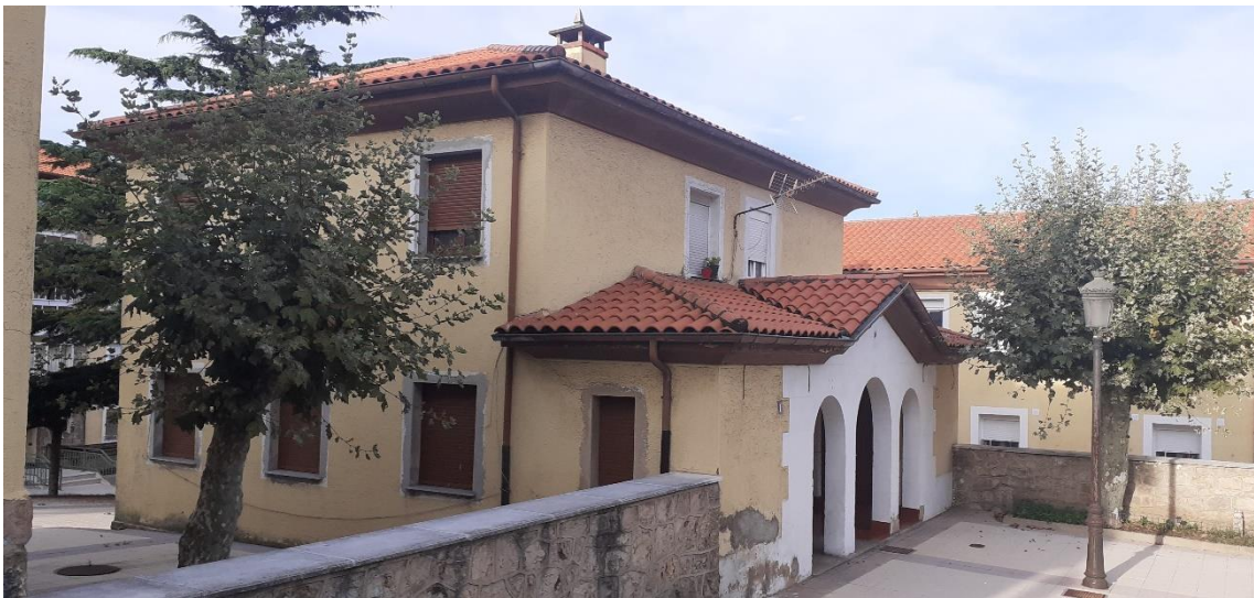
Fig. 29: ejemplo de vivienda unifamiliar adosada que sirve como ejemplo de los preceptos de la arquitectura de FET. Fuente: la autora.
