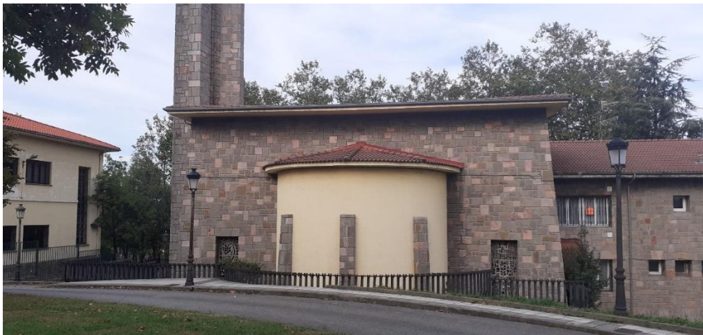
Figs. 27 y 28: vistas de conjunto de la Iglesia (centro), Casa-Cuna (izquierda) y Escuelas (derecha). Fuente: la autora.
