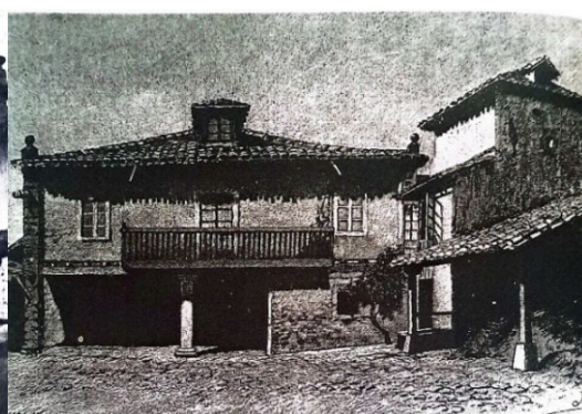
Fig. 9. Casona de los Velarde antes de su rehabilitación
