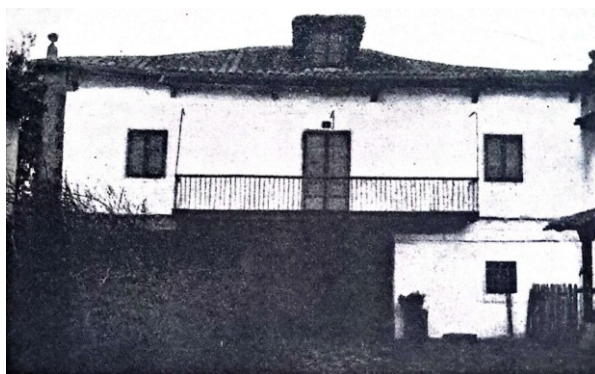
Fig. 8. Casona de los Velarde antes de su rehabilitación
