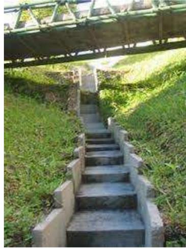
Figura 31. Escaleras disipadoras del drenaje
