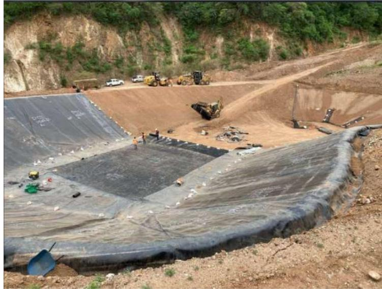
Figura 2. Colocación de capa geosintética.
