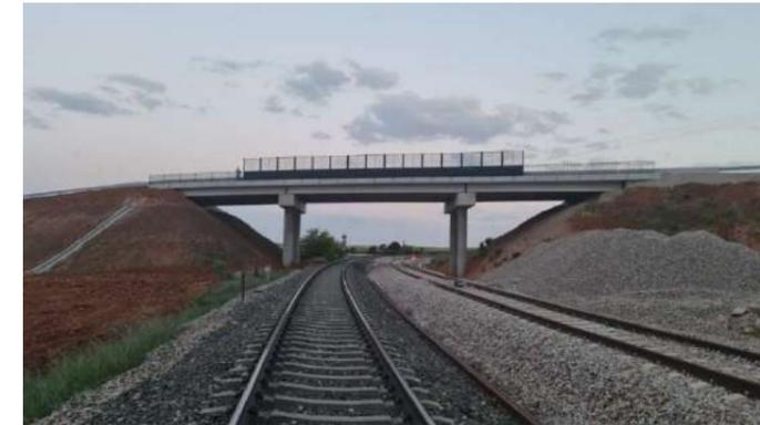
Figura 3. Paso superior con losa in situ.
