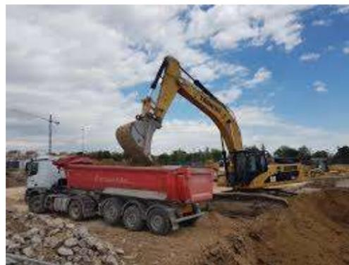
Figura 1. Carga de material excavado con retroexcavador.
