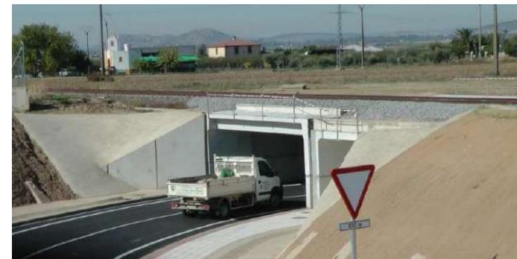
Figura 2. Paso inferior ferroviario.
