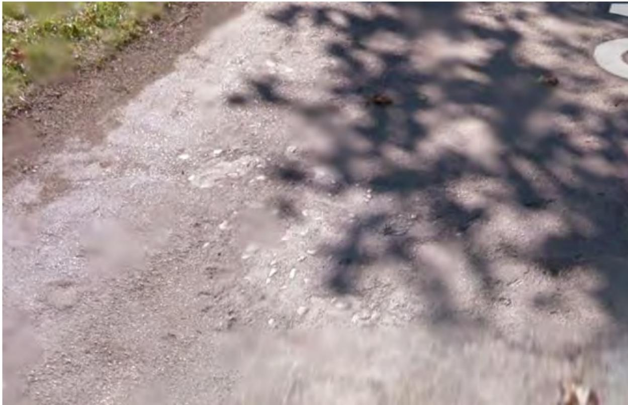
*Imagen 6. Detalle del deterioro del firme.*
