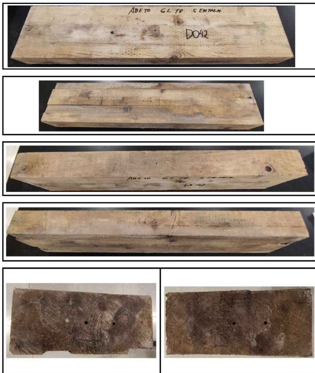
Figura 193. Estado inicial de la viga GLULAM sumergida D042 de abeto (GL18).
