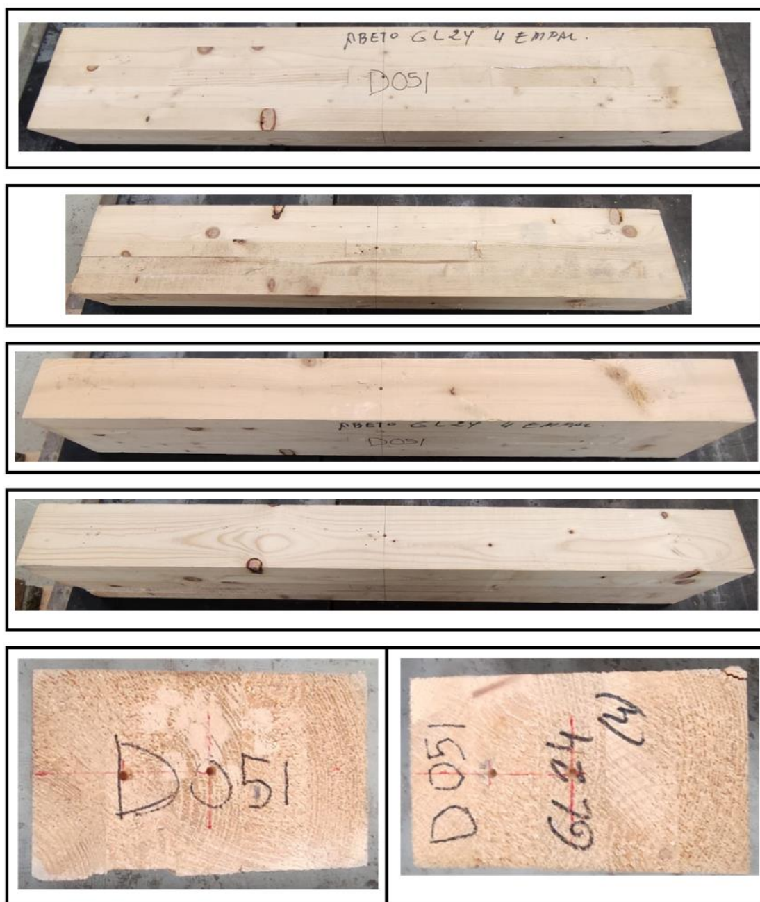
Figura 191. Estado inicial de la viga GLULAM sana D051 de abeto (GL24).
