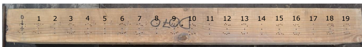
Figura 109. Cara superior de la viga sumergida D070 de madera de pino silvestre sin tratamiento GL24.
