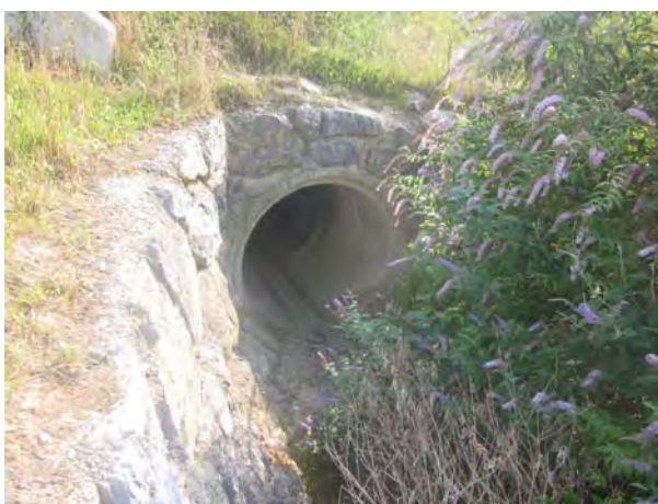
FOTO-1: Regata Lekun (Tubo Ø2000 bajo ramal de acceso) y paso inferior.
