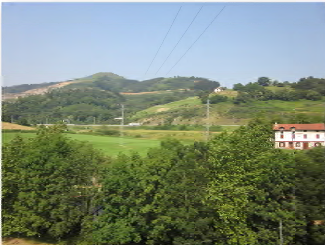
FOTO-24: Vista vaguada a rellenar. Postes línea 13.2Kv.
