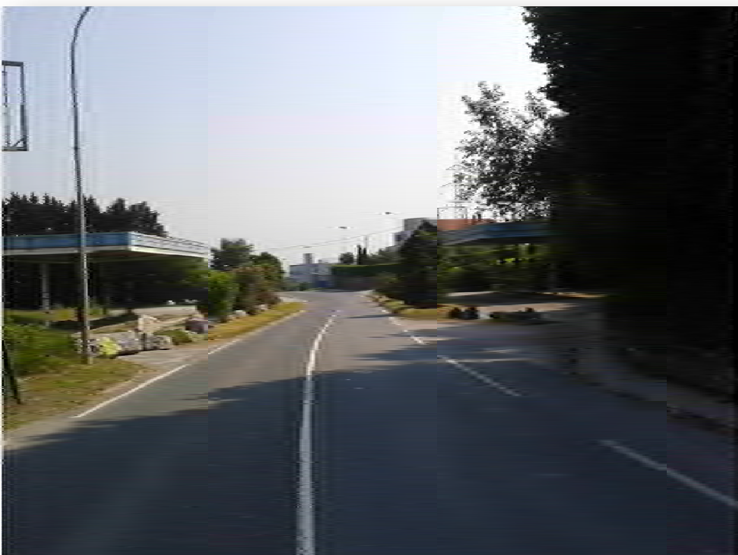
FOTO-29: Antigua estación de servicio desde GI-3722 (antigua GI-131).
