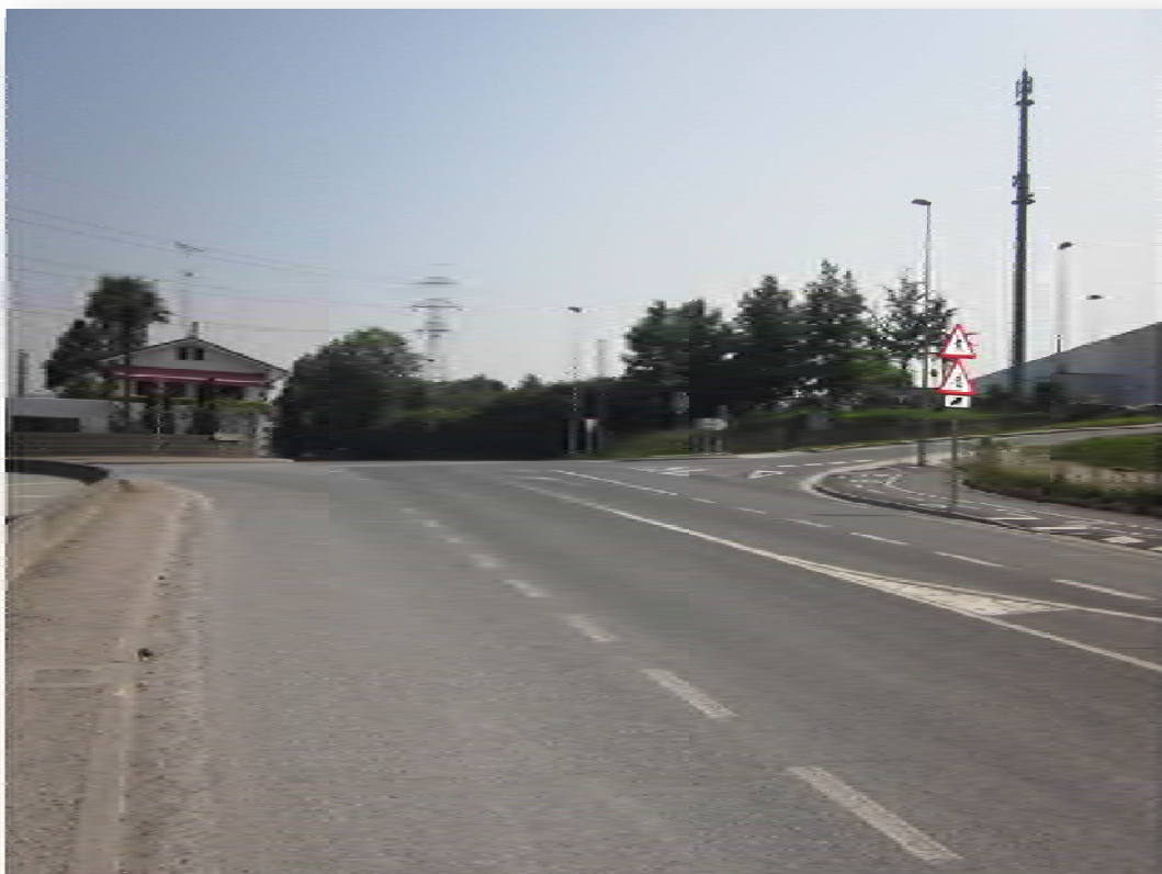
FOTO-42: Vista cruce de acceso al polígono Ergoien.
