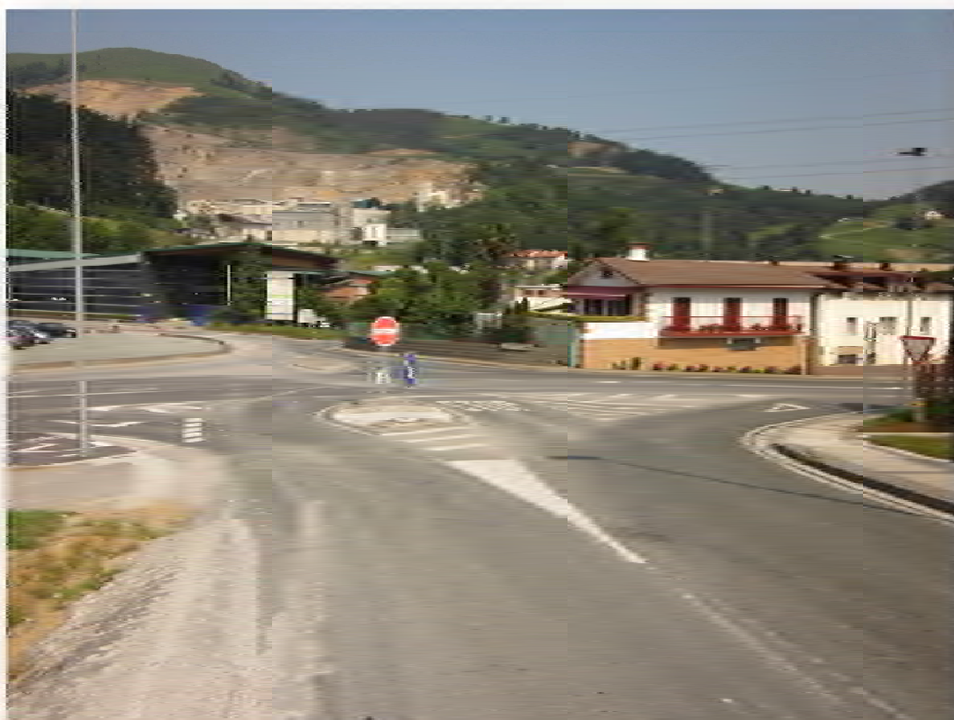
FOTO-43: Vista cruce de acceso al polígono Ergoien.
