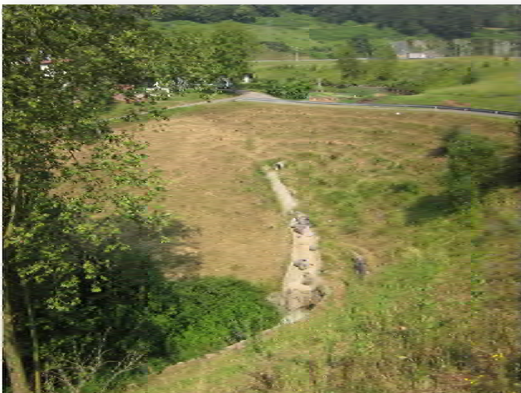
FOTO-23: Detalle obra drenaje bajo ramal de acceso.
