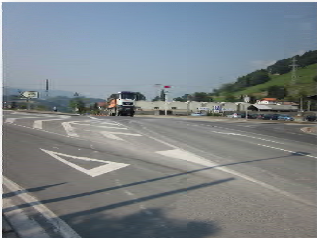
FOTO-44: Vista cruce de acceso al polígono Ergoien.
