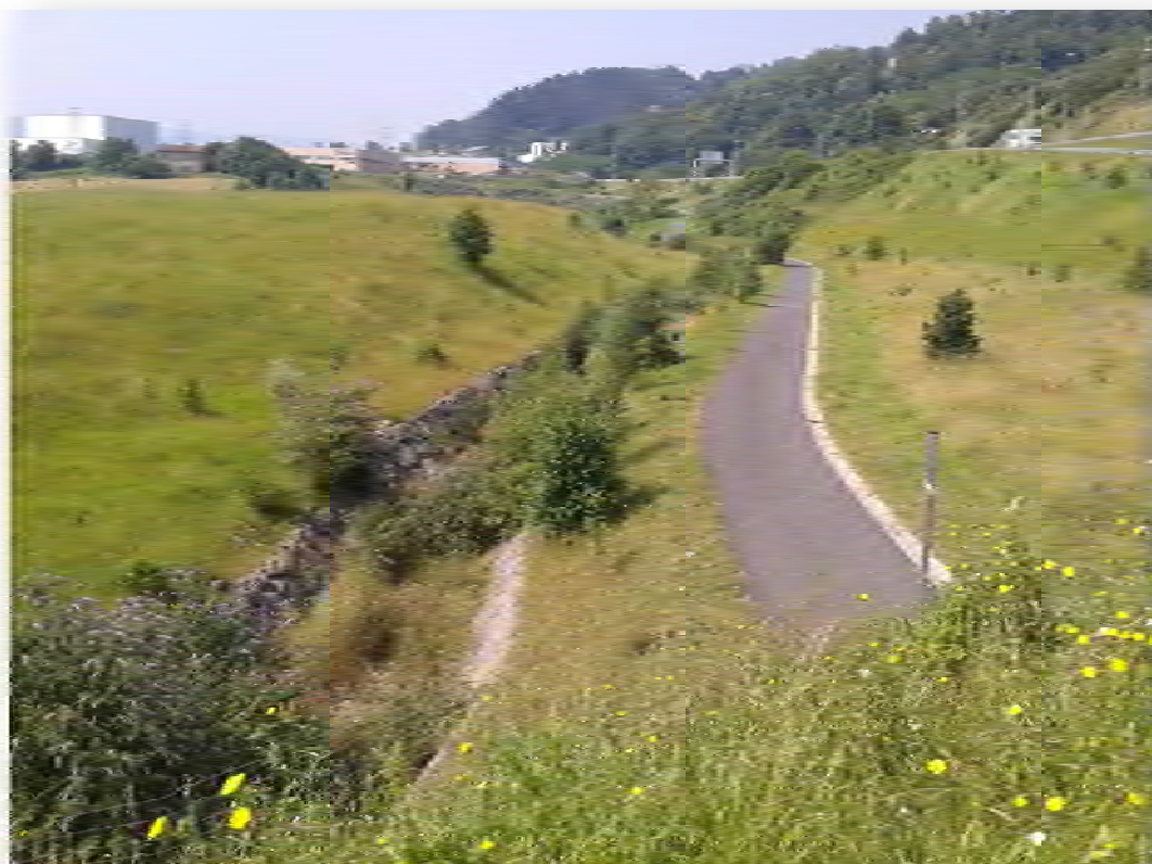
FOTO-18: Vista polígono depósito sobrante desde paso inferior ramal de acceso.
