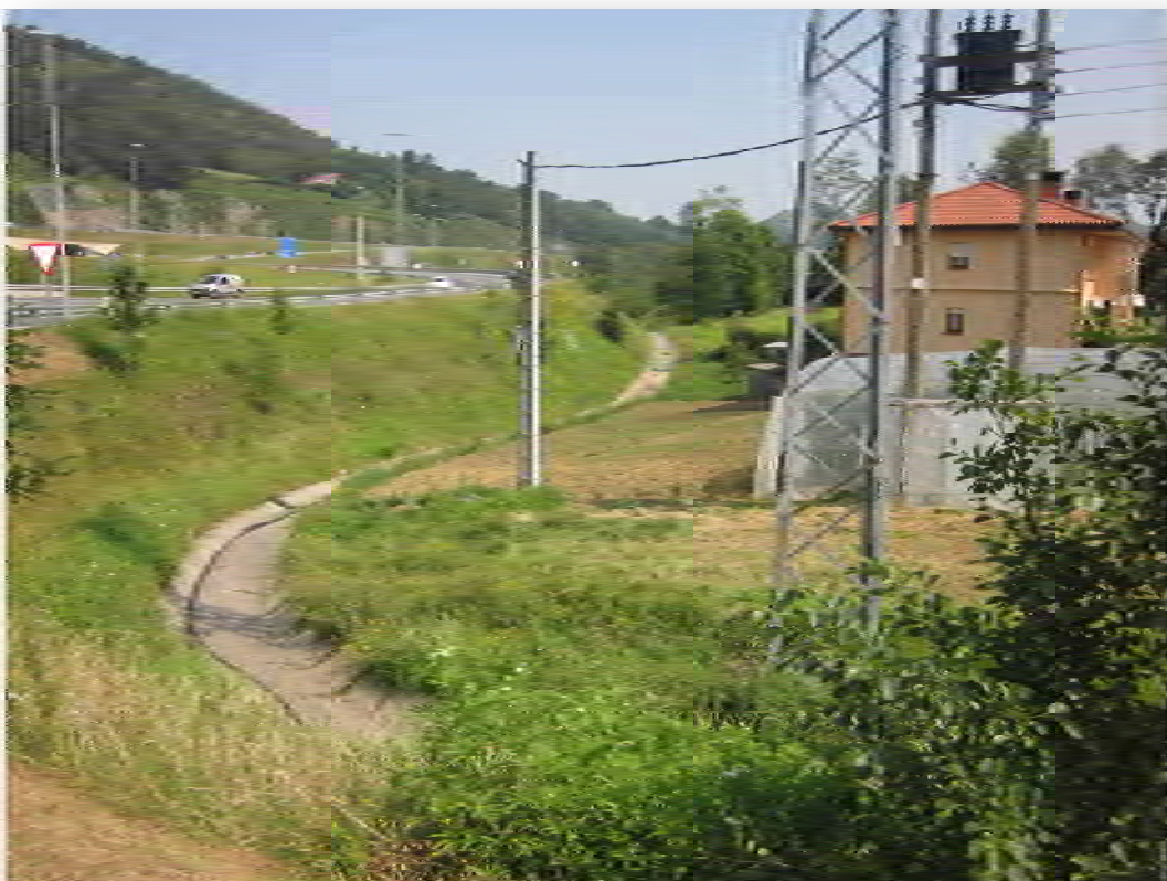
FOTO-21: Cuneta perimetral. Postes eléctricos de baja tensión.
