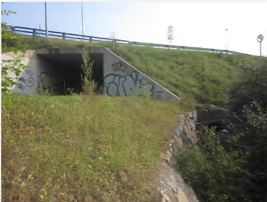
FOTO-13: Regata Lekun (Tubo Ø2000 bajo ramal de acceso) y paso inferior.
