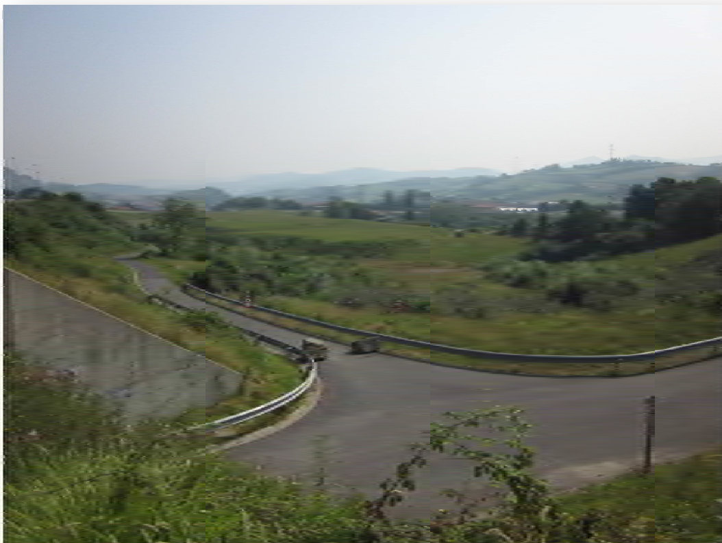
FOTO-9: Vista deposito de sobrantes y camino peatonal (futuro bidegorri).
