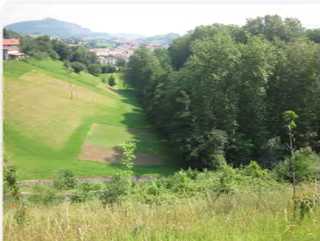
FOTO-19: Bajante escalonada regata Lekun. Conexión con regata Akan.
