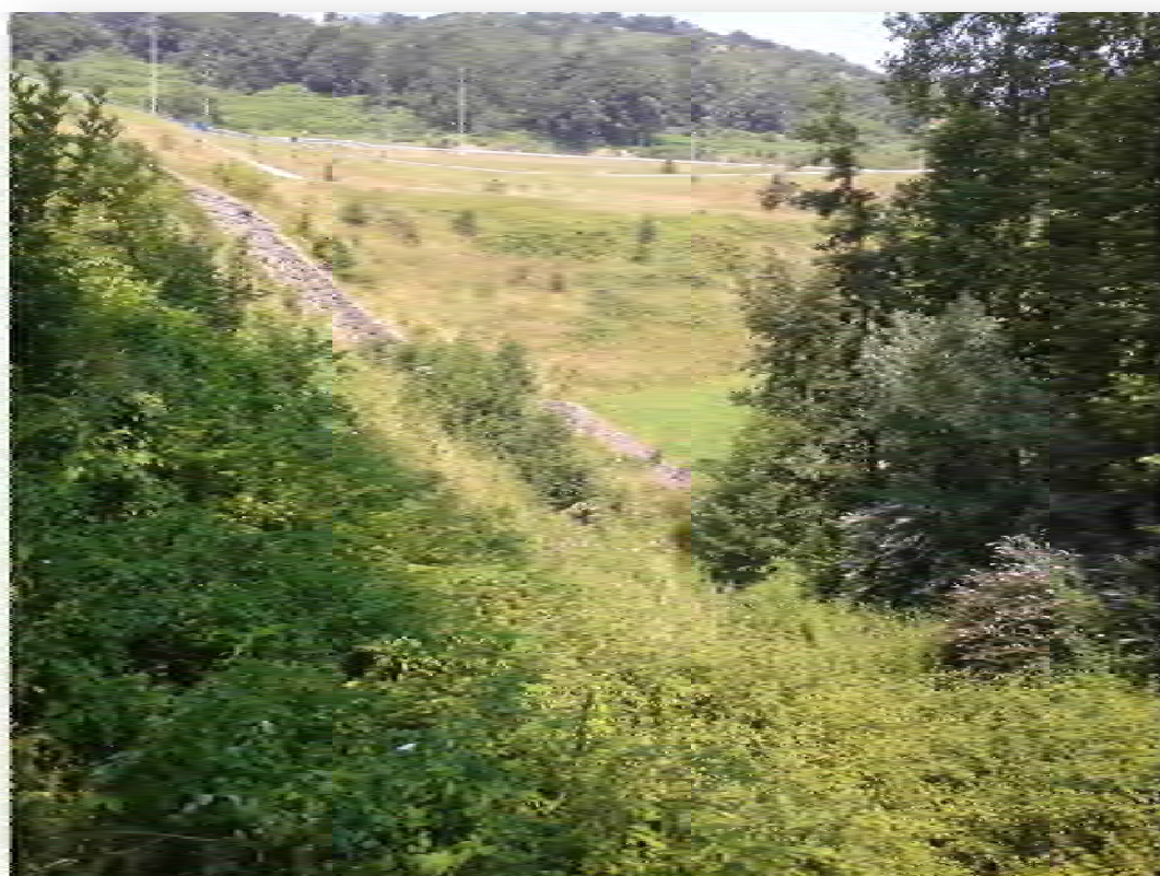
FOTO-17: Bajante escalonada regata Lekun. Conexión con regata Akan.
