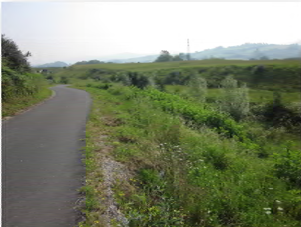
FOTO-11: Vista polígono depósito sobrantes desde camino peatonal.
