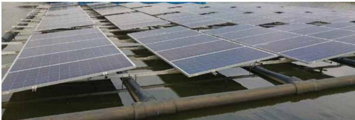
Figura 2-3 Sistema de flotación por pontones [2]
