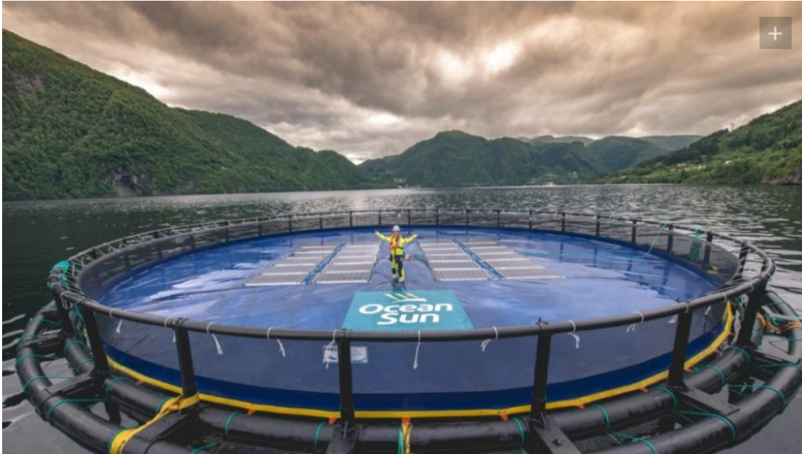
Figura 2-4. Sistema de flotación con membrana [2]
