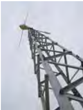
Ilustración 12: Torres de celosía.
