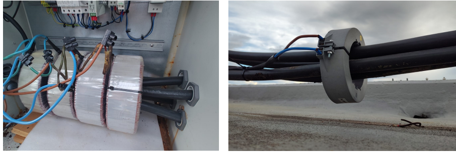
Figura 3.9: Fotografías del montaje. (a) Figura izquierda: Acoplamiento de los cuatro toroidales. (b) Figura derecha: Fotografía del trafo de intensidad de núcleo partido.
