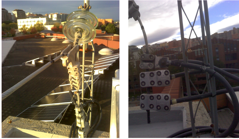
Figura 3.4: Fotografías del montaje y la instalación del prototipo de simulación. (a) Figura izquierda: Herrajes y aisladores. (b) Figura derecha: Conectores a los cuatro conductores RVK.
