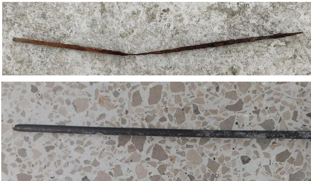
Estado de un alambre transversal del informe de inspección (arriba) [2] y estado de un alambre transversal recibido para su ensayo (abajo)
