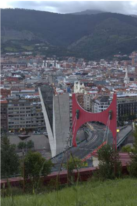
Ilustración 23. Fotografía del puente de La Salve con tráfico. Fuente: autor.
