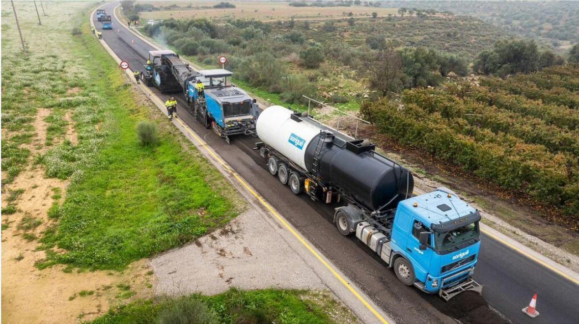
*18 Rehabilitación en C-45 mediante reciclaje de firme in-situ con emulsión. [25]*
