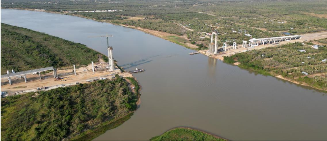
Figura 15. Vista general de la fase inicial de construcción de los estribos y las torres del Puente Bioceánico.
