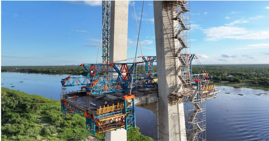
Figura 20. Vista del carro de avance empleado para la construcción del vano central del Puente Bioceánico.
