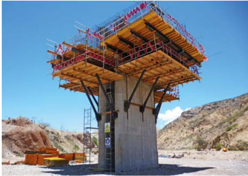
Figura 2. Encofrado de dovela 0 en el Puente Allcomachay (Perú), [3].
