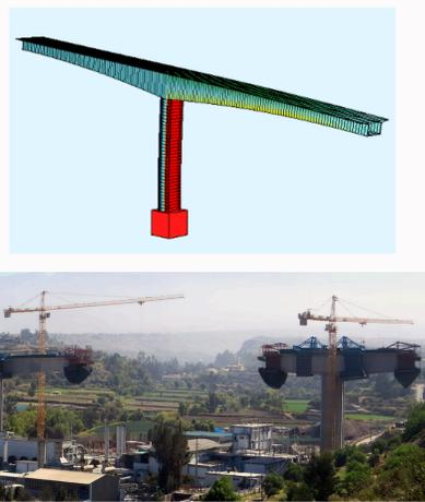
Puente Bioceánico. MEF (IS) VS Construcción real
