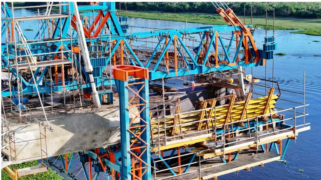
Figura 21. Vista del frente de avance del carro.
