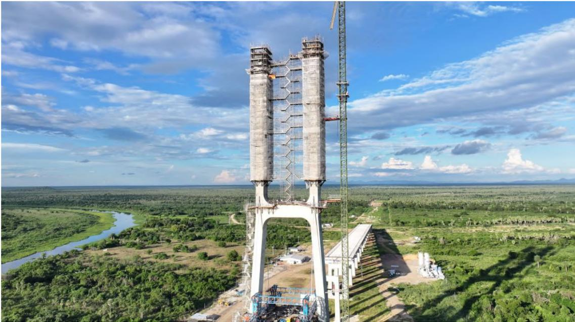
Figura 17. Montaje de la torre del Puente Bioceánico situada en la orilla de Carmelo Peralta.
