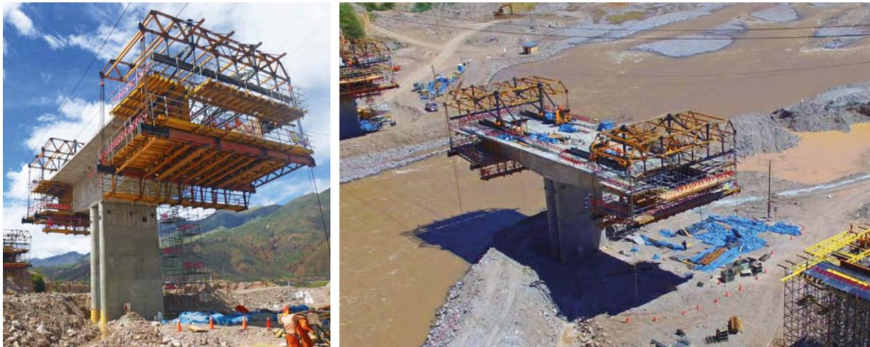
Figura 3. Construcción simétrica mediante el carro de avance en el Puente Allcomachay (Perú), [3].
