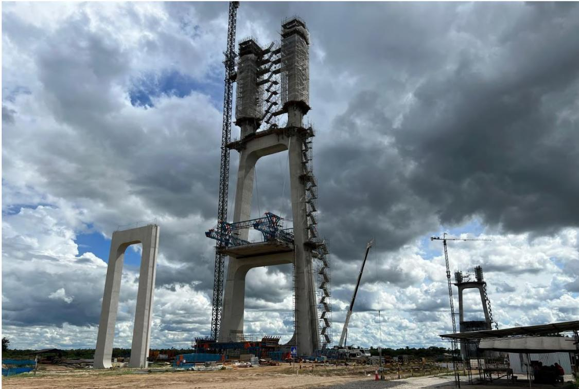
Figura 19. Vista general de la fase de montaje del carro de avance sobre la dovela 0.
