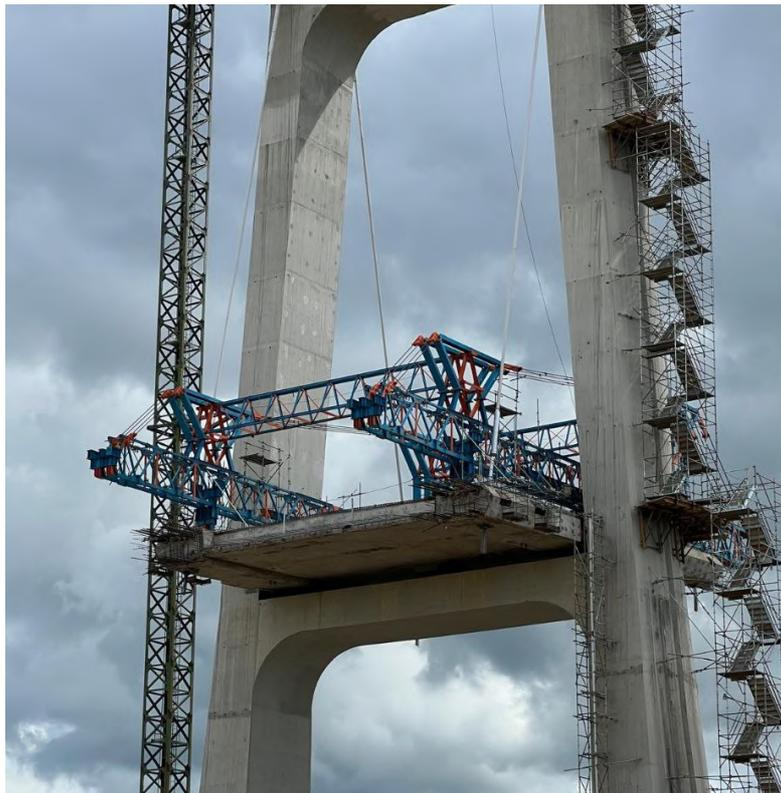
Figura 18. Fase de montaje del carro de avance sobre la dovela 0.
