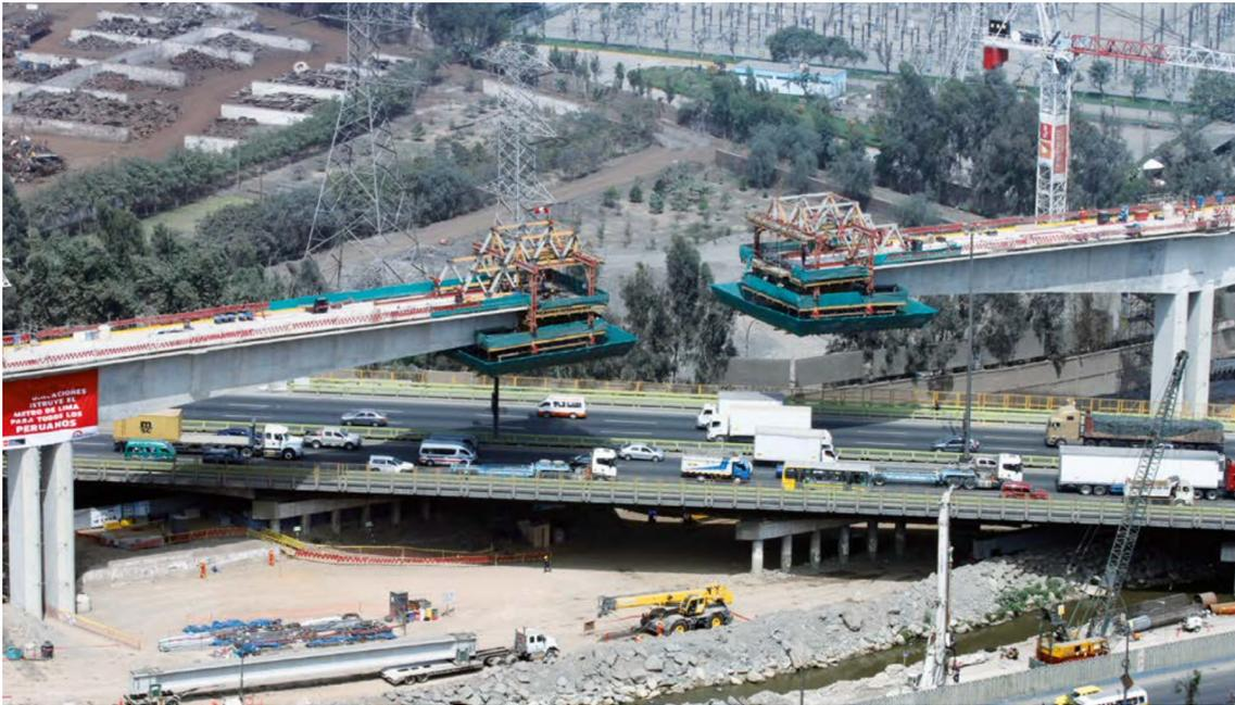
Figura 4. Construcción del viaducto del tren eléctrico de Lima, Perú, mediante carro de avance, [3].
