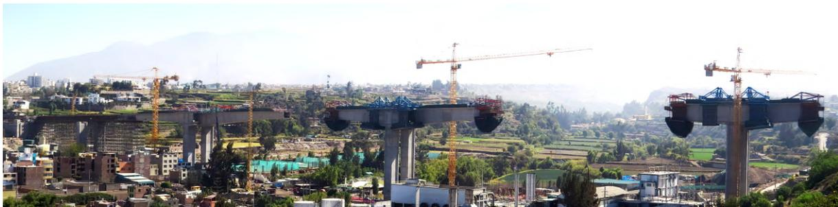
Figura 25. Fase de construcción de los tableros [14].
