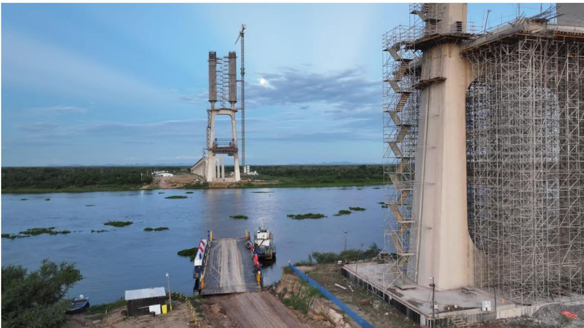
Figura 16. Montaje de las torres del Puente Bioceánico vista en dirección al río Paraguay.
