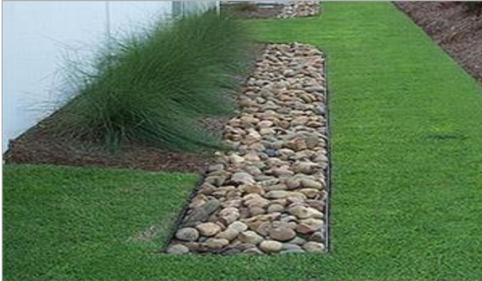
Figura 9 Zanjas de Infiltración
