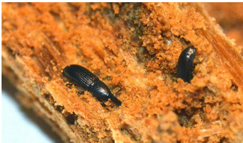
Ilustración 13: Afección por insecto xilófago (escarabajos)
