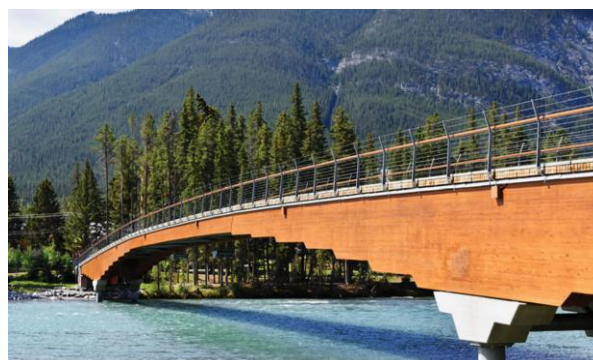
Ilustración 18: Bow River Pedestrian Bridge
