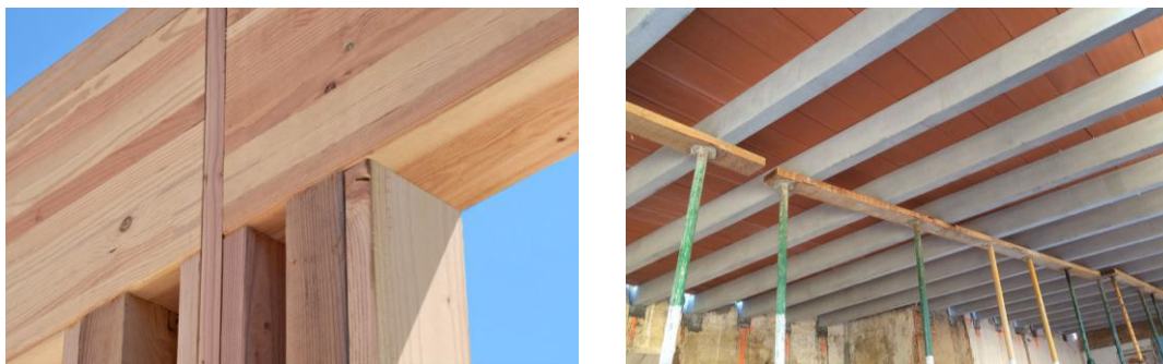
Ilustración 8: Vigas de Glulam y de hormigón
