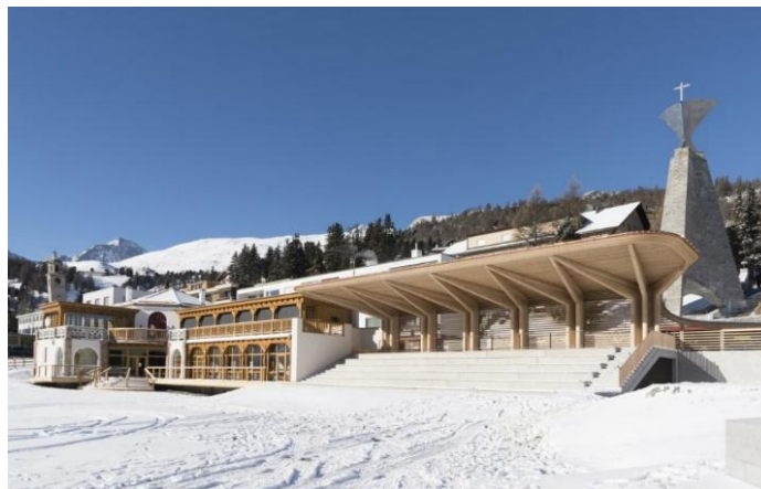
Ilustración 10: Sobrecarga por nieve de una estructura de madera encolada
