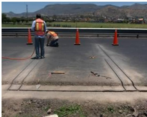
*Figura 5 Sensores piezoeléctricos.*
