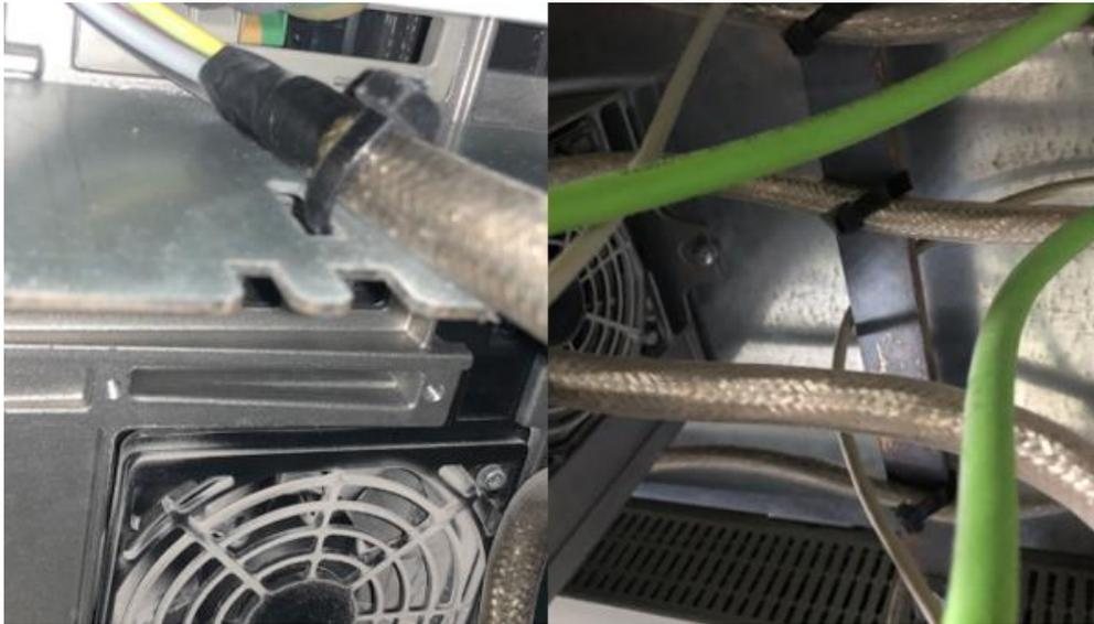
Figura 14. Estado de los cables Profibus DP y conexiones a la salida del variador. [14]
